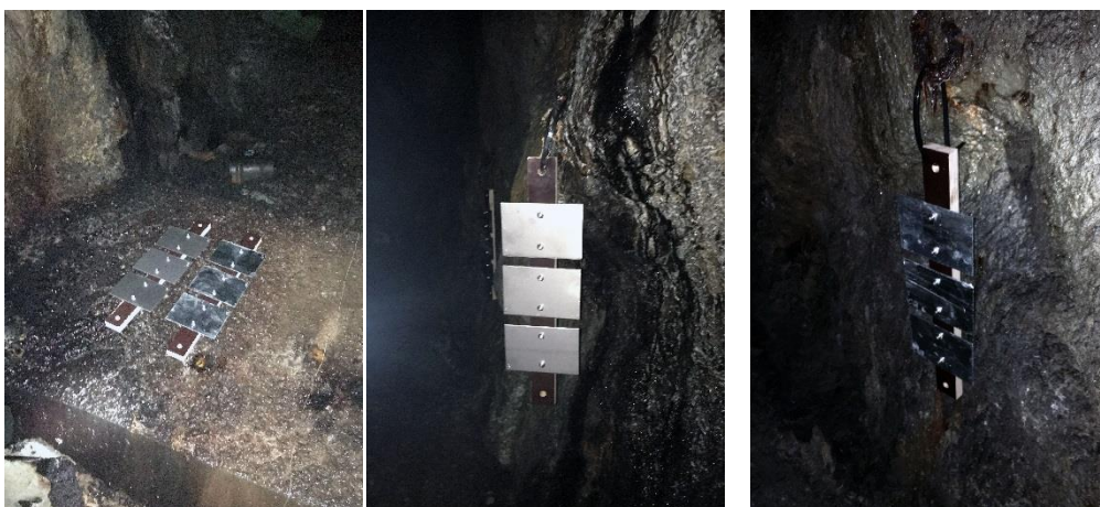
Figur 6. Prøveplater plassert bak hvelv i Oslofjordtunnelen; horisontale prøver ble lagt på et betongfundament på bakken (t.v.) og vertikale prøver ble hengt i gamle festebolter (midt og t.h.)
