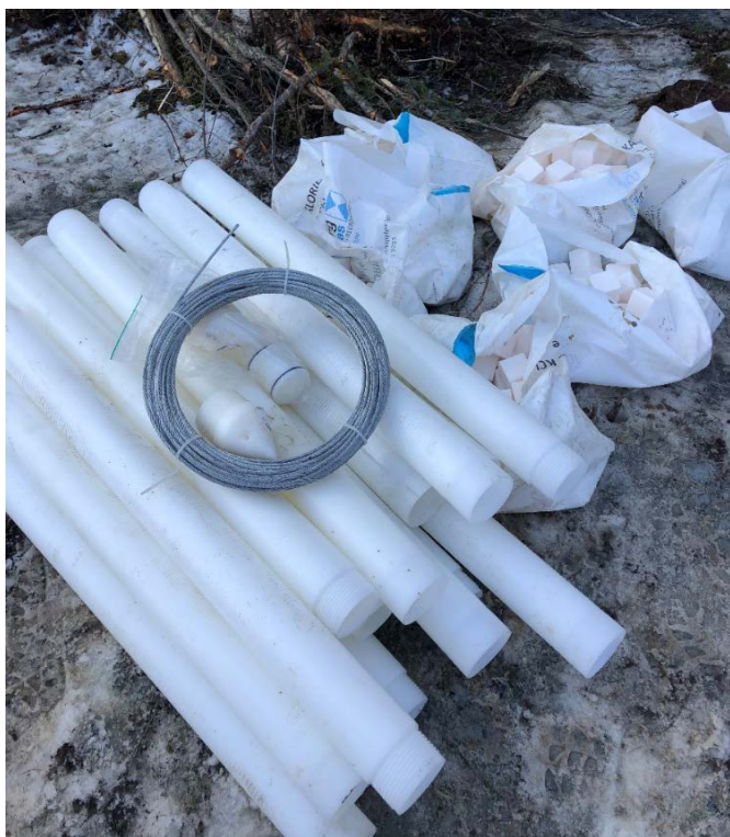
Figur 18 Ø90 mm perforerte PE-miljøbrønnrør og KCl-kubar før installasjon.
