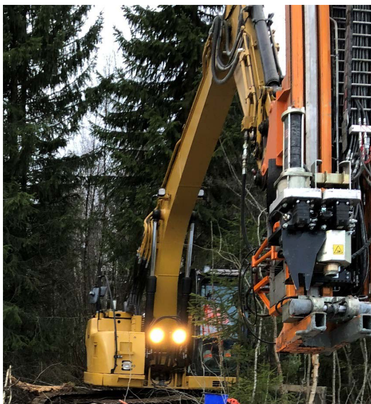
Figur 9 Gravemaskin med bortårn
