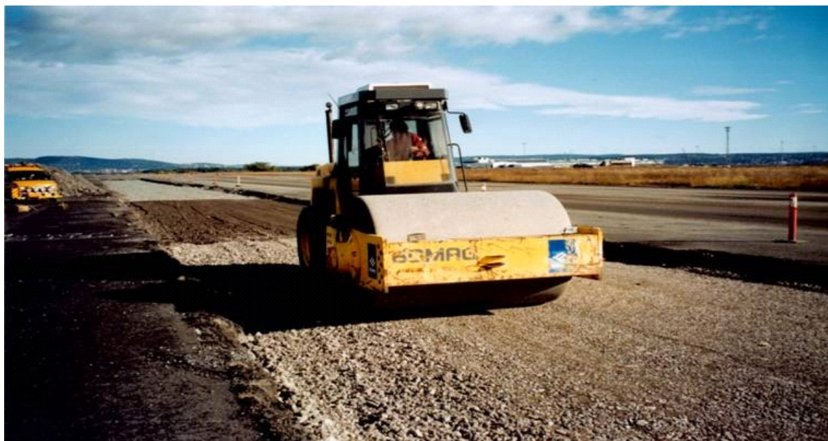
Figur 18: Utlegging av alternative forsterkningslag på Fornebu forsøksveg
