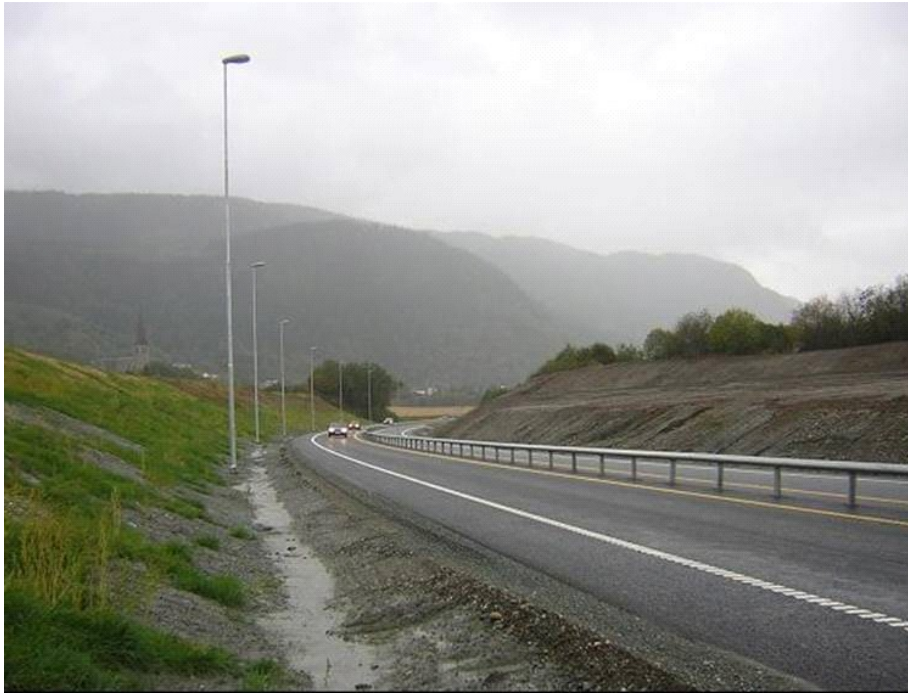
Figur 26: Forsøksstrekning på E6 Melhus, høsten 2004
