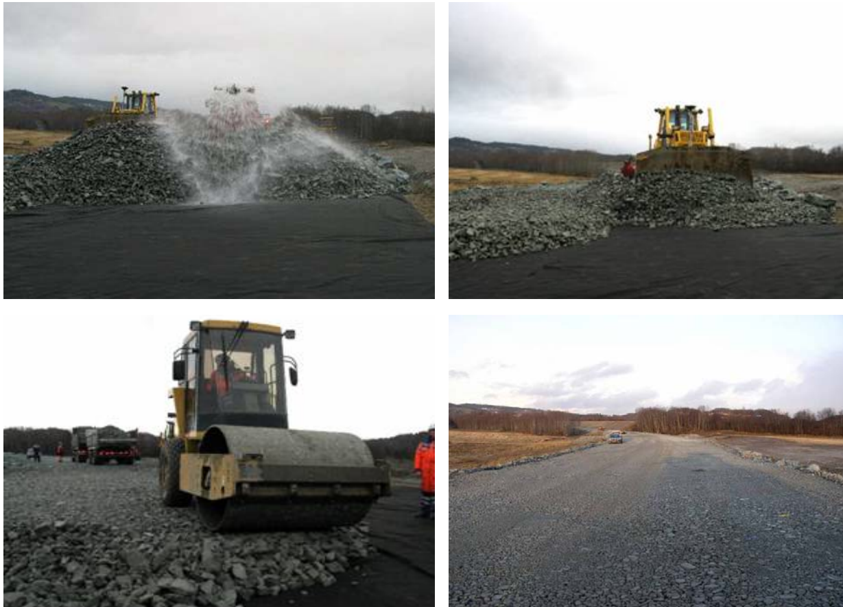
Figur 1: Rikelig vanning før utlegging og komprimering skåner materialene og sikrer best mulig resultat (E6 Melhus)
