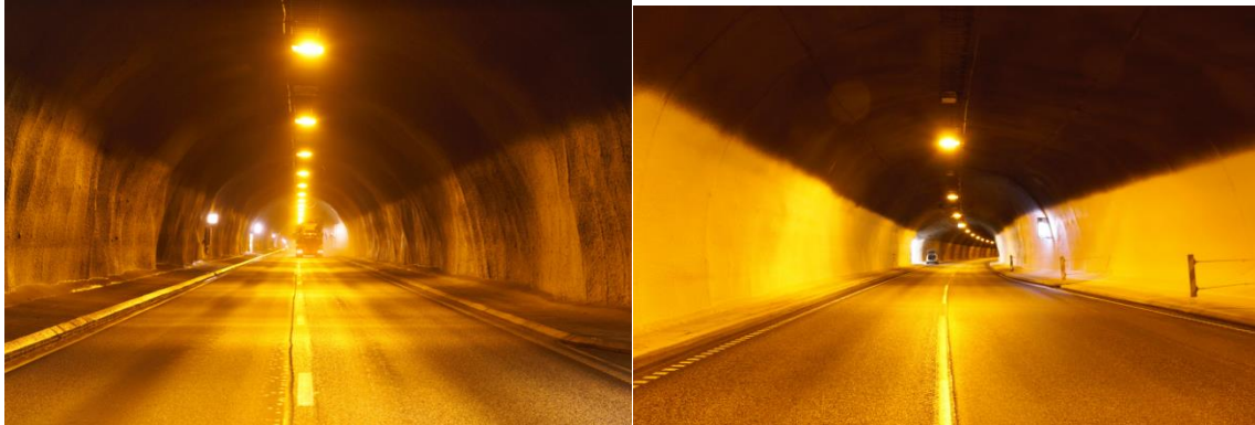
Figur 11 Bilde før vask (t.v.) og etter vask og hvitting i Damsgårdtunnelen (t.h.).
