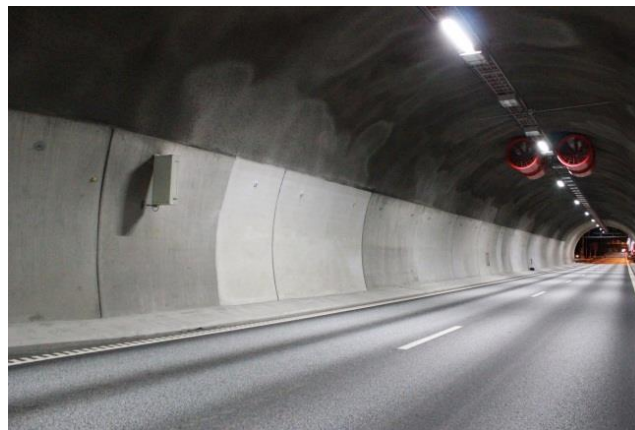
Figur 21 Bilde av forsøksfelt i Askimporten tunnel
