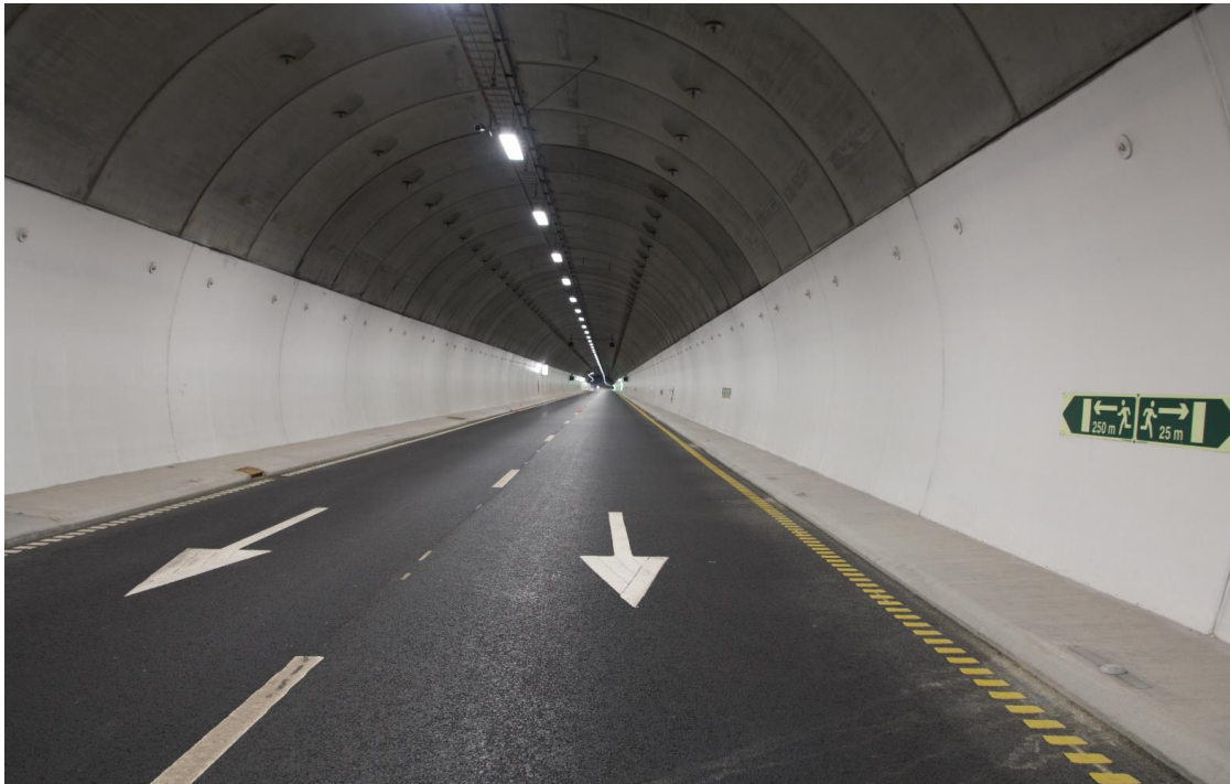
Figur 13 Foto før åpning for trafikk i Strindheimtunnelen
