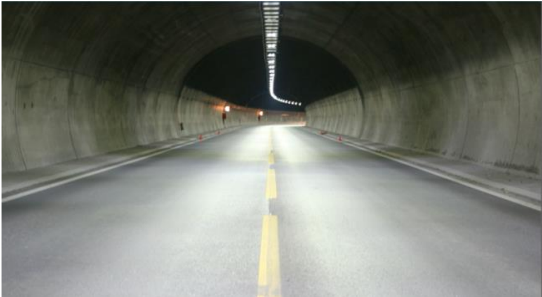
Figur 9 Foto av indre sone i Vabakken tunnel
