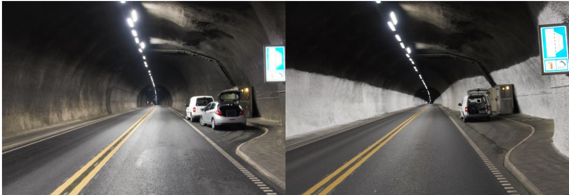
Figur 12 Foto før vask og etter vask og hvitning av Væretunnelen
