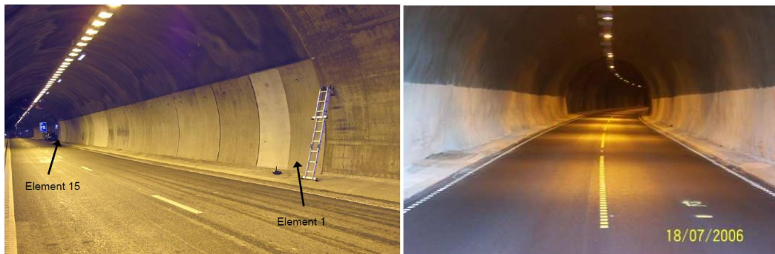
Figur 16 Eksempel på lyse veggelementer/hvitmalte vegger i tunnel (statens vegvesen, 2011)
