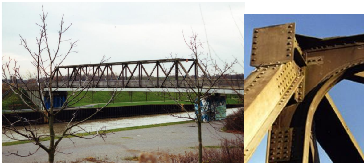
Figur 8: Naglet Aluminium bru fra 1956 – fortsatt i bruk. [34] Material: EN AW- 6082, Spenn på 44.20 m, total bredde 5,10 m, anvendbar bredde på 4.50 m, kjørebane 3,50 m. Nettovekt 25 tonn, for et kjøretøy opp til 12 tonn.
