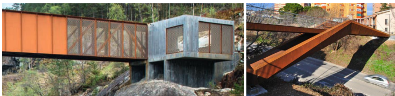
Figur 12: Corten stål i bru. Vnstre: HØSE bru, 2014, høyre: Can Gili footbridge, 2009
