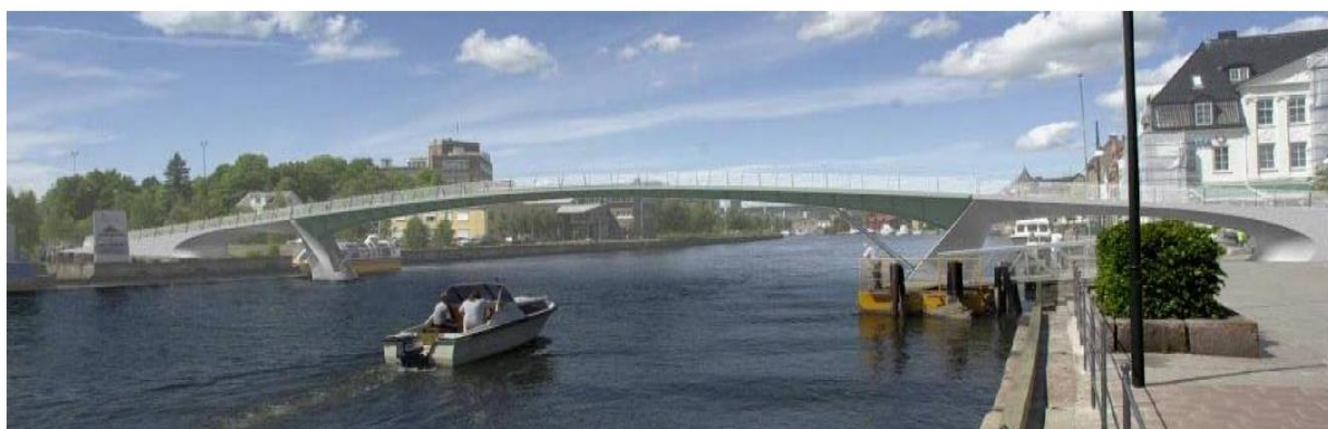
Figur 4: FRP bru realisert i Fredrikstad, Norge [21]
