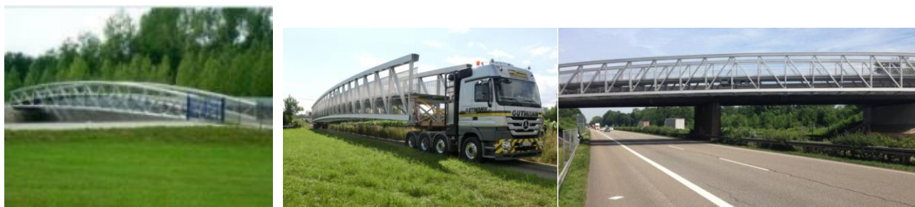
Figur 11: Venstre: bru i Aluminium, Tyskland, 2008 [35]; høyre: bru over motorvei A5, Tyskland 2009 [36]
