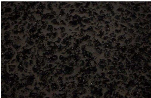
Figur 4: Støv på vegen før rengjøring mellom hjulspor (foto: Ellinor Hansen)
