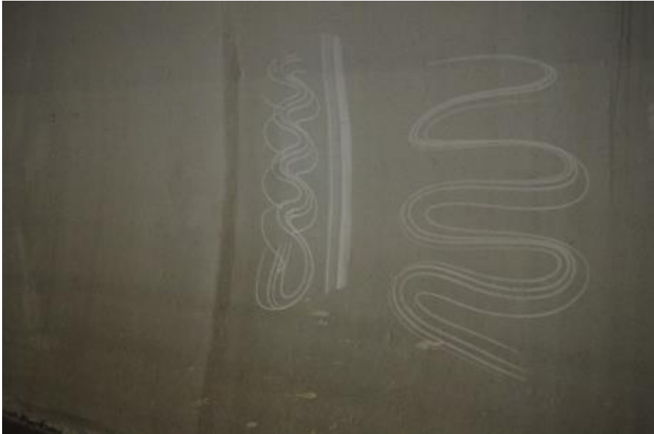
Figur 57: Vasking kun med vann og ikke mekanisk påvirkning gir dårligere resultat (foto: Brynhild Snilsberg)
