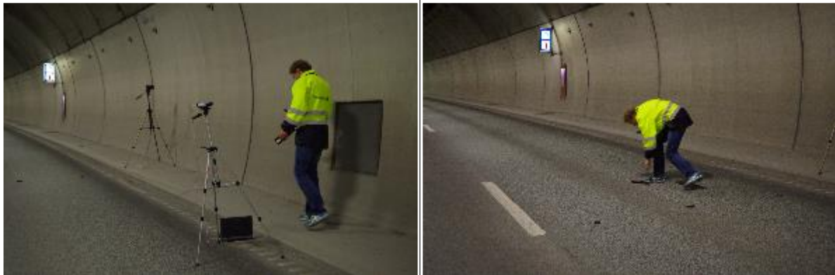
Figur 26: Måling av lyshet på tunnelveggen og på vegbanen (foto: Brynhild Snilsberg)
