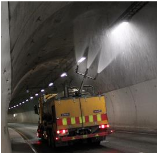
Figur 15: Spyling av armatur og tak med tunnellvasker 1 (foto: Ellinor Hansen)
