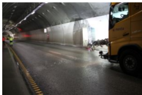
Mesta Møre og Romsdal vasker tunnelveggen med børste i Strindheimtunnelen i Trondheim. (Foto: Ellinor Hansen)
