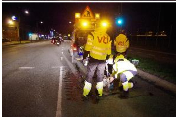
Figur 34: Prøvetaking med WDS i Haakon VII gate (foto: Brynhild Snilsberg)
