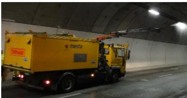
Figur 14: Spyling av tak og armatur (foto: Dagfin Gryteselv)
