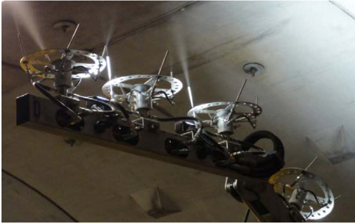
Figur 20: Nærbilde av rotordyser for vask av tunneltak og-vegger før oppstart (foto: Dagfin Gryteselv)
