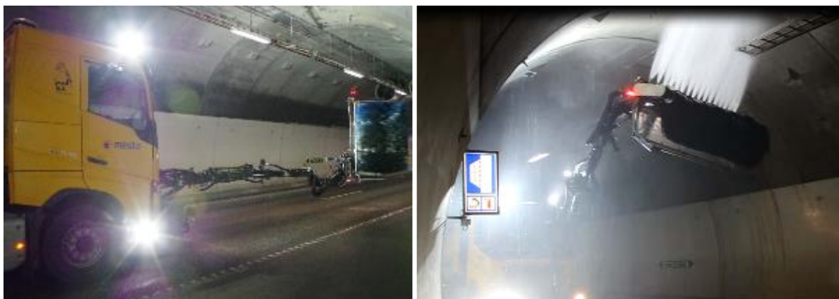
Figur 8: Poleringsbørste for vegg med mulighet for spyling av tak, armatur og vegger (foto: Brynhild Snilsberg og Ellinor Hansen)
