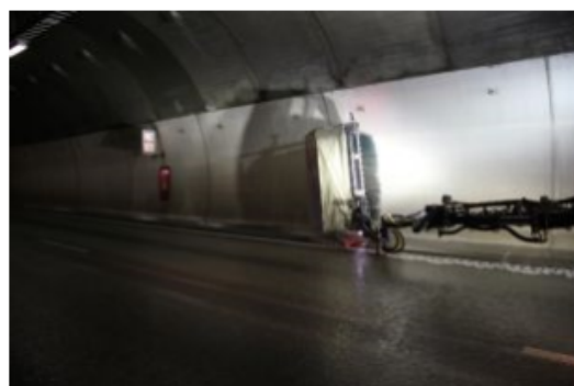
Tunnelveggen vaskes med børste. Vi ser tydelig hvor mye renere tunnelveggen er bak børsten (Foto: Ellinor Hansen)
