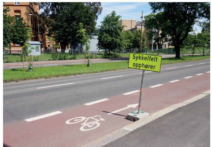
Figur 39. Bildet viser et skilt om at "sykkelfeltet opphører". Skiltet står plassert i sykkelfeltet, og er ikke høyt nok til at syklende kan komme under skiltplaten.
