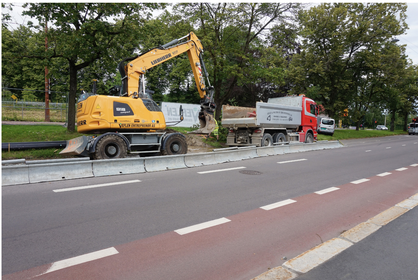
Figur 10. Anleggsvirksomhet innenfor studieområdet. Et helt kjørefelt ble stengt på grunn av dette, noe som kan ha hatt innvirkning på resultatene.
