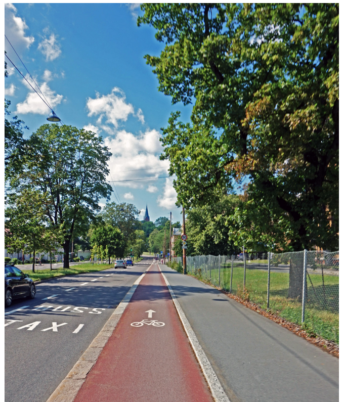
Figur 2. Illustrasjonen viser situasjonen ved Ullevål sykehus i retning vest i juli 2019. Siden 2017 har det blitt opparbeidet envegsregulert sykkelveg med fortau langs strekningen.
