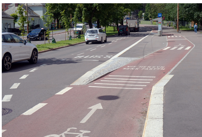
Figur 32. Bildet viser rumlefelt, påskriften "VIS HENSYN SENK FARTEN" og gangfelt, samt sykkelensymbol og retningsindikator i sykkelvegen.
