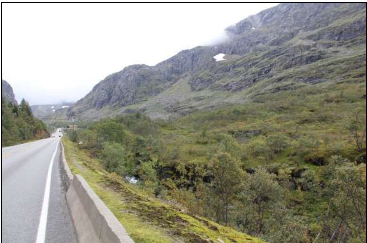
Figur 5. Seljestad: Dagens E134 med innslaget til Seljestadtunnelen i bakgrunnen. Den gamle veien over Røldalsfjellet går opp Seljestadjuvet bak til venstre. Opp til høyre ligger Histeinsnuten (1 344 moh.), og i fremkant renner Histeinselva, som er del av det vernede vassdraget Opo m/Låtefoss.
