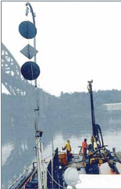
Figur 58 Signalmerker i dagslys for borflåte i arbeid med geotekniske undersøkelser
