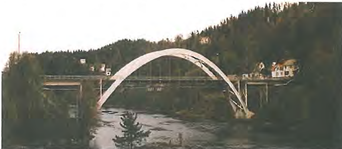
Foto 3.1 Blakstad bru sett fra nedstrømsside
