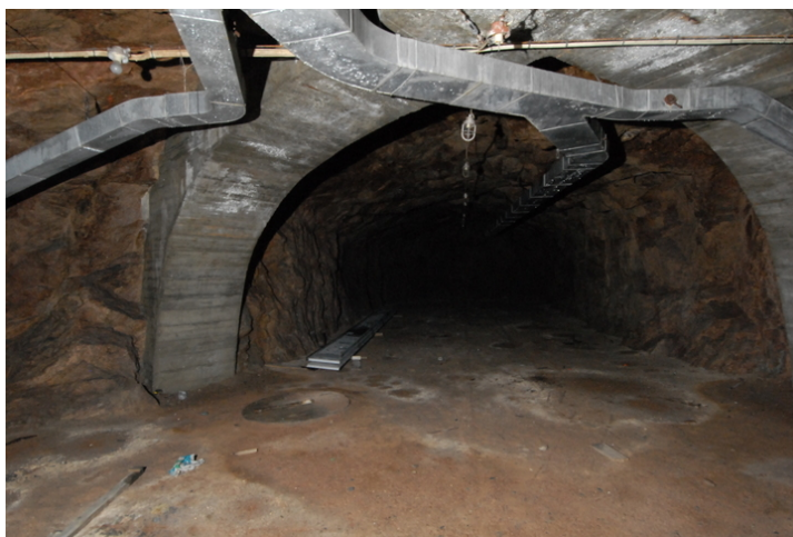
Garasje sett fra inngang. Foto: Leif Anker, Forsvarsbygg.
