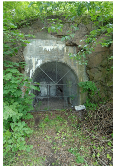
Inngang Valhalla alarmplass. Foto: Leif Anker, Forsvarsbygg
