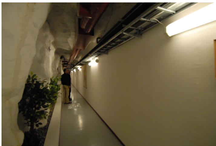
Hovedkorridoren sett fra innenfor vestibylen. Foto: Leif Anker.
