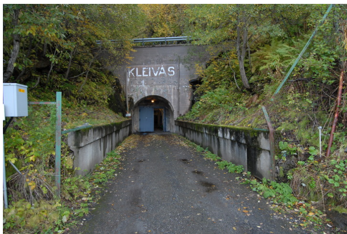
Anleggets inngang i sørøstlig retning. Foto: Leif Anker, Forsvarsbygg.
