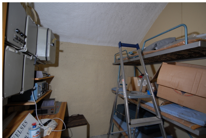
Radio/forlegningsrom. Foto: Leif Anker, Forsvarsbygg
