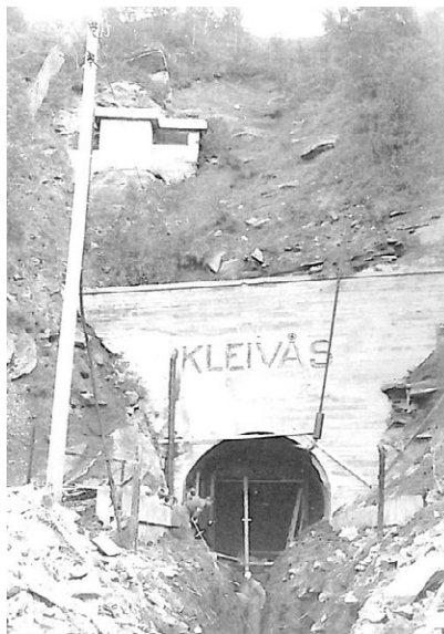
Begynnelsen på 1960-tallet. Luftinntak og nødutgang i skråningen. Opphavsrett: Nordland SFD.
