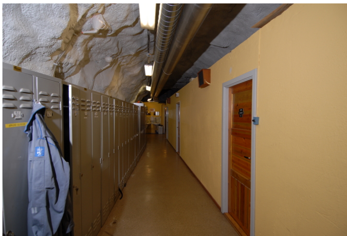
Korridor mot KO-plass. Foto: Leif Anker, Forsvarsbygg
