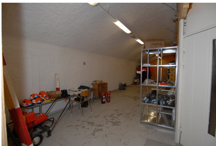
Forlegningssal, avdelt med lager. Foto: Leif Anker, Forsvarsbygg
