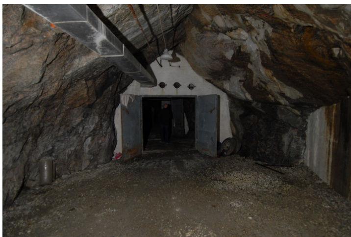
Materiellplass mot sluse. Foto: Leif Anker, Forsvarsbygg
