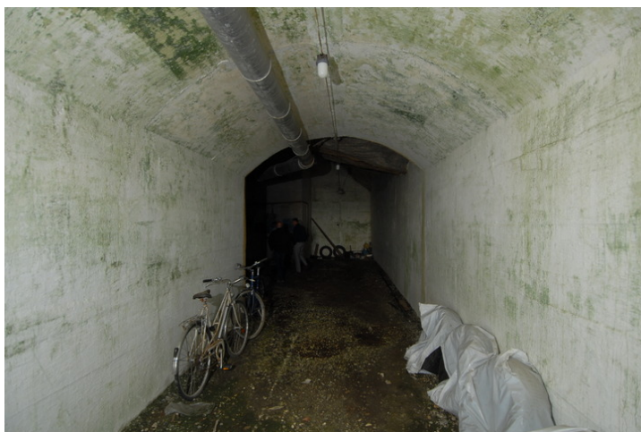
Garasje fra utgang. Foto: Leif Anker, Forsvarsbygg
