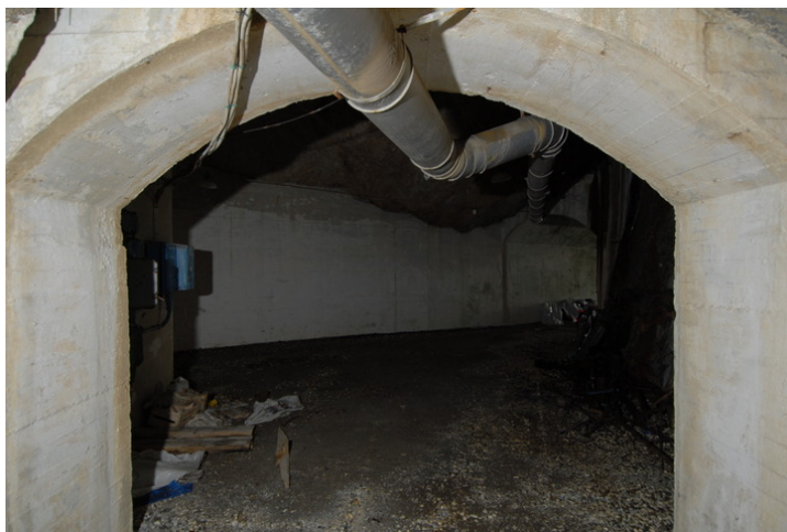
Garasje mot utgang. Foto: Leif Anker, Forsvarsbygg
