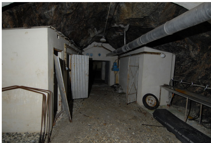
Forhall mot sluse. Foto: Leif Anker, Forsvarsbygg
