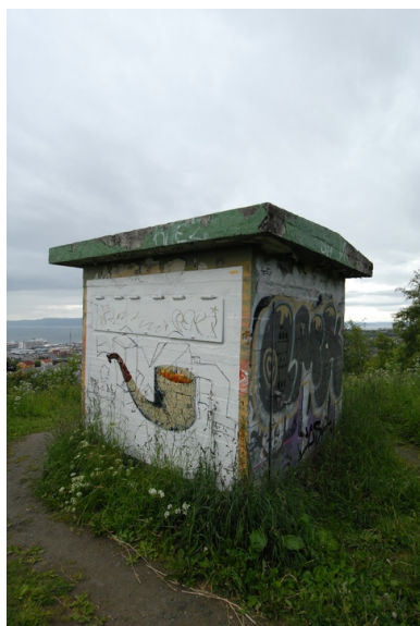
Fasadene mot sørvest og sørøst. Foto: Leif Anker, Forsvarsbygg.
