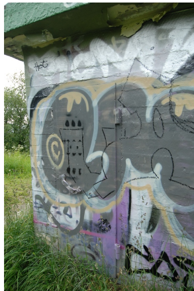
Inngang med ståldør på nordøstsiden. Foto: Leif Anker, Forsvarsbygg.
