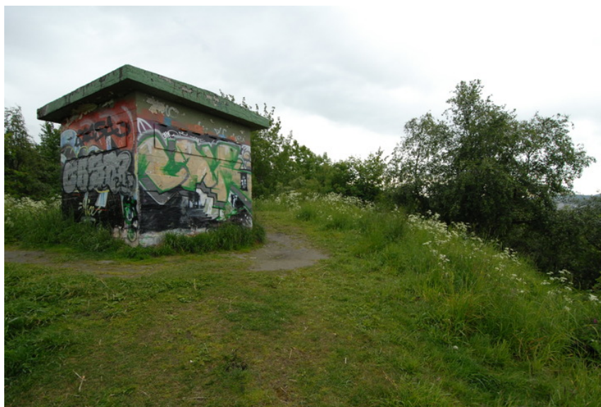
Nordvest- (og nordøst) fasaden. Foto: Leif Anker, Forsvarsbygg.
