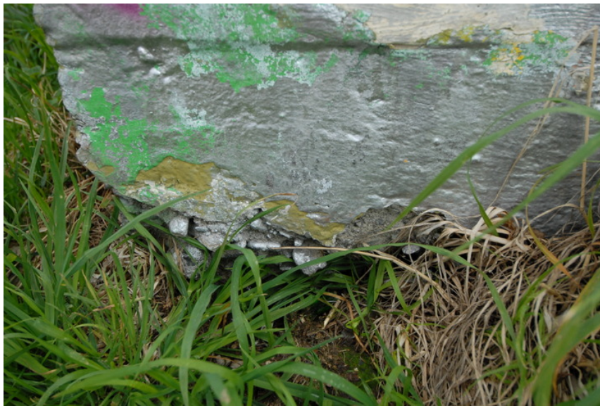
Fundament. Foto: Leif Anker, Forsvarsbygg.
