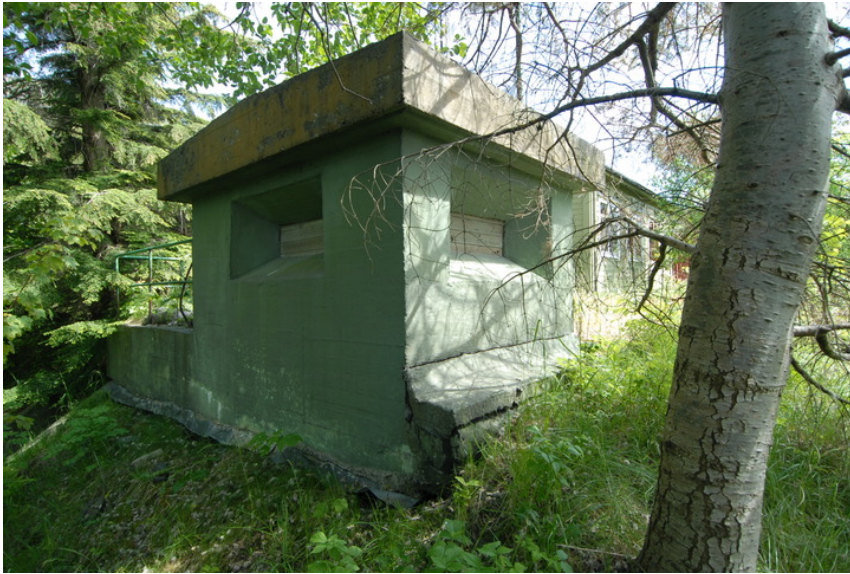
Utkikkskiosk mot SØ. HV-brakka rett sørøst for anlegget skimtes mellom kiosken og treet. Foto: Leif Anker, Forsvarsbygg.
