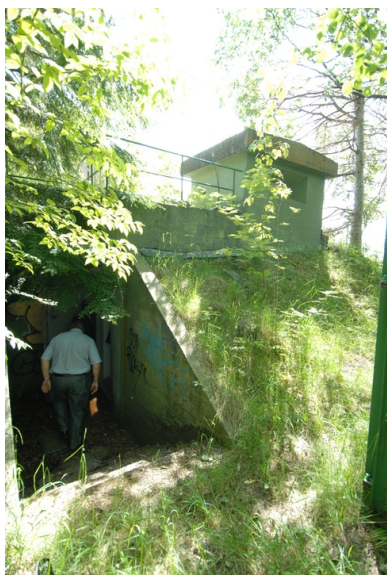
Inngang til utkikkskiosk sett mot ca. sør. Foto: Leif Anker.
