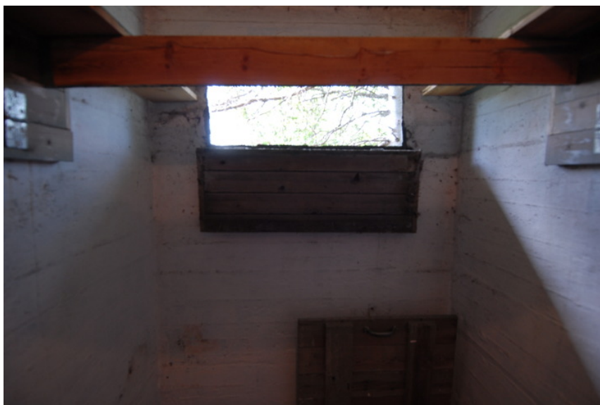
Atkomst til utkikkskiosken er fra bunker gjennom luke i gulvet. Foto: Leif Anker.
