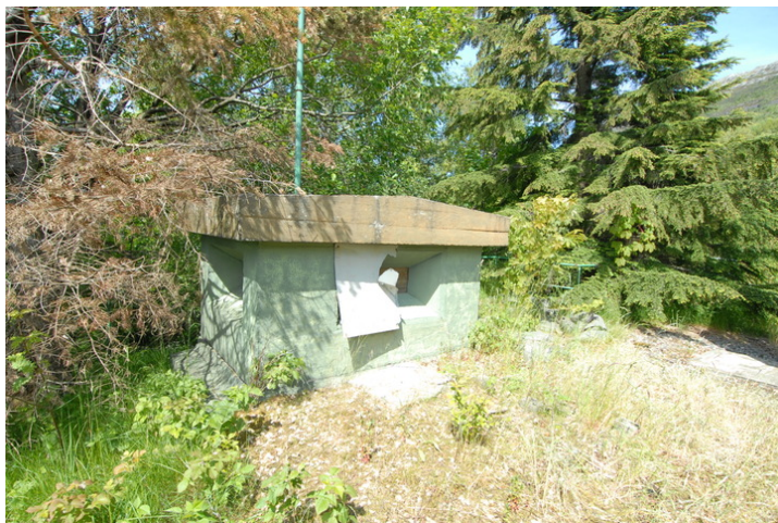
Utkikkskioskens fasade mot sør og vest. Foto: Leif Anker, Forsvarsbygg.
