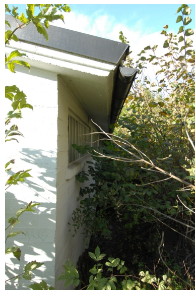
Glimt av østfasade. Foto: Leif Anker, Forsvarsbygg.
