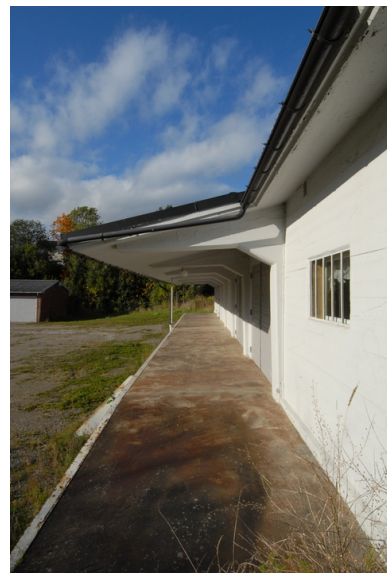
Lasterampe vestfasade. Foto: Leif Anker, Forsvarsbygg.
