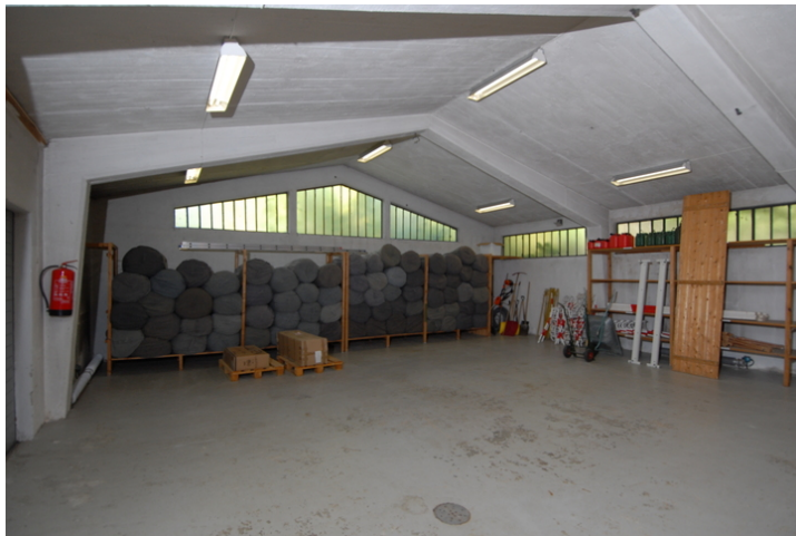
Interiør mot nord. Foto: Leif Anker, Forsvarsbygg.
