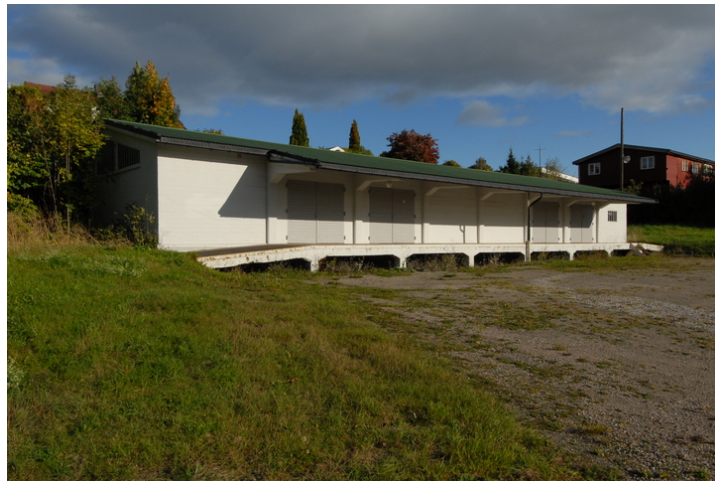
Bygg mot nordvest. Foto: Leif Anker, Forsvarsbygg.
