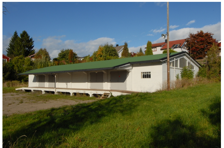
Bygg sett fra sørvest. Foto: Leif Anker, Forsvarsbygg.
