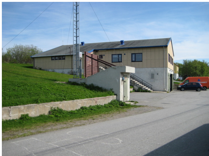
Oversiktsbilde tatt fra vest. Inngang kommandoplass midt i bildet. Foto: Frode Karlsen, Forsvarsbygg.
