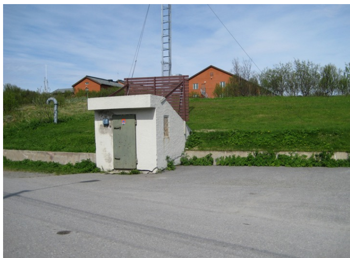
Inngang fjellanlegget sett mot NØ. Vadsø fengsel i bakgrunnen. Foto: Ukjent.
