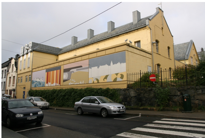
Anlegget sett fra sør. Bak muren luftegård og cellefløy, til venstre tilbygg på cellefløy. Opphavsrett: Statsbygg.
