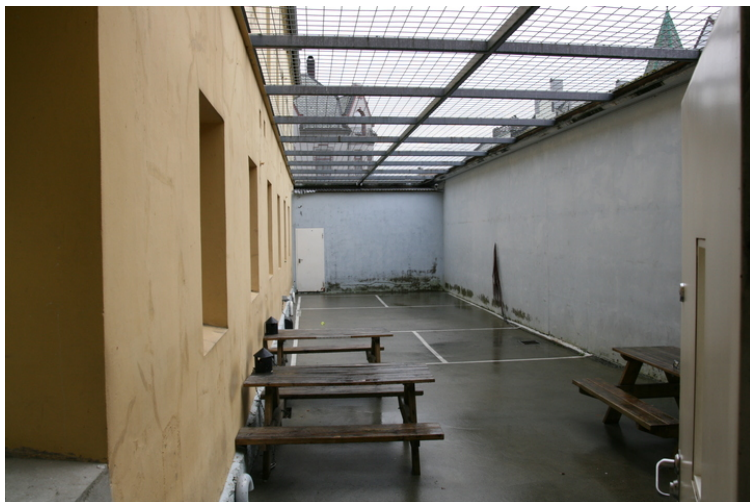
Tidligere kjøkkenhage bak celledelen er nå luftegård. Opphavsrett: Statsbygg.
