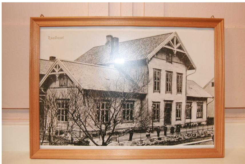
Foto av forbygningen slik den opprinnelig var bygget. Opphavsrett: Statsbygg.
