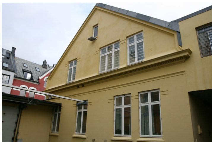
Forbygningens vestfasade. Det er celler også i 2. etasje i forbygningen. Opphavsrett: Statsbygg.
