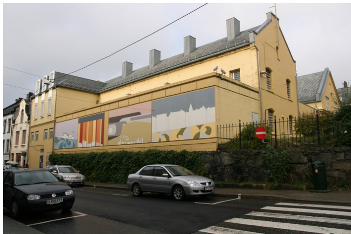
Anlegget sett fra sør. Bak muren lufttegård og cellefløy, til venstre tilbygg på cellefløy. Opphavsrett: Statsbygg.
