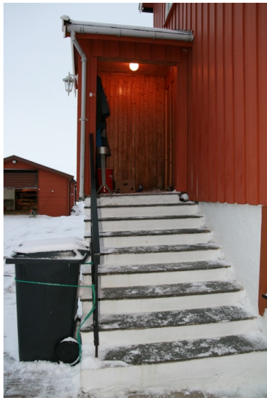
Utvendig trapp til hovedinngang. Opphavsrett: Statsbygg.
