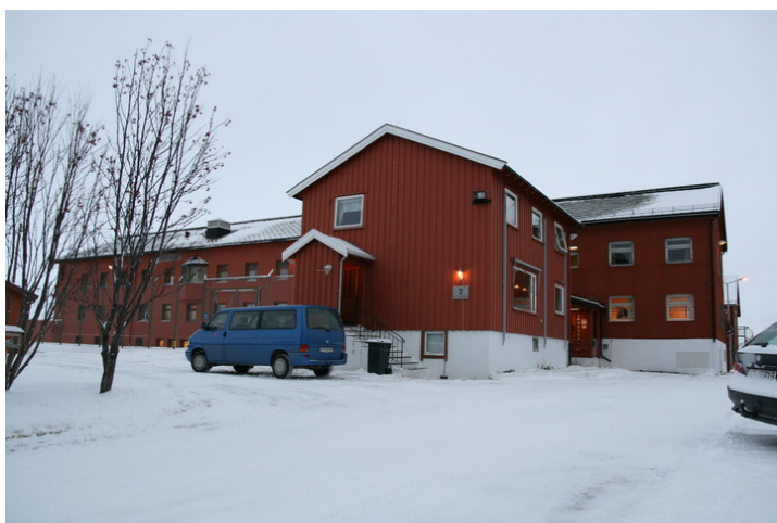
Inspektørboligen og cellebygningen fra hovedadkomsten. Opphavsrett: Statsbygg.
