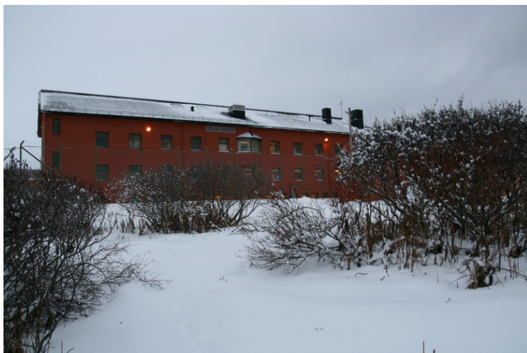
Cellefløy. Nytt tilbygg fra venstre til og med karnappvindu. Opphavsrett: Statsbygg.
