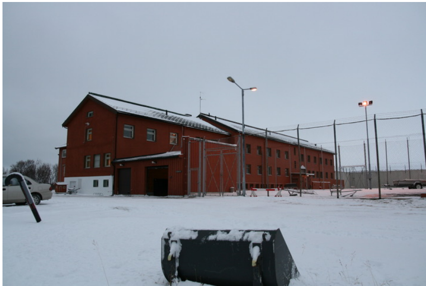
Cellebygning sett fra verksted. Opphavsrett: Statsbygg.
