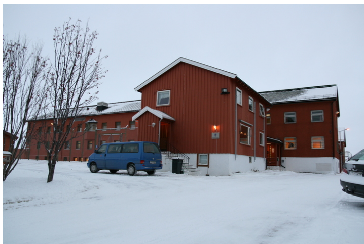
Vadsø fengsel med direktørboligen i forgrunnen. Opphavsrett: Statsbygg.
