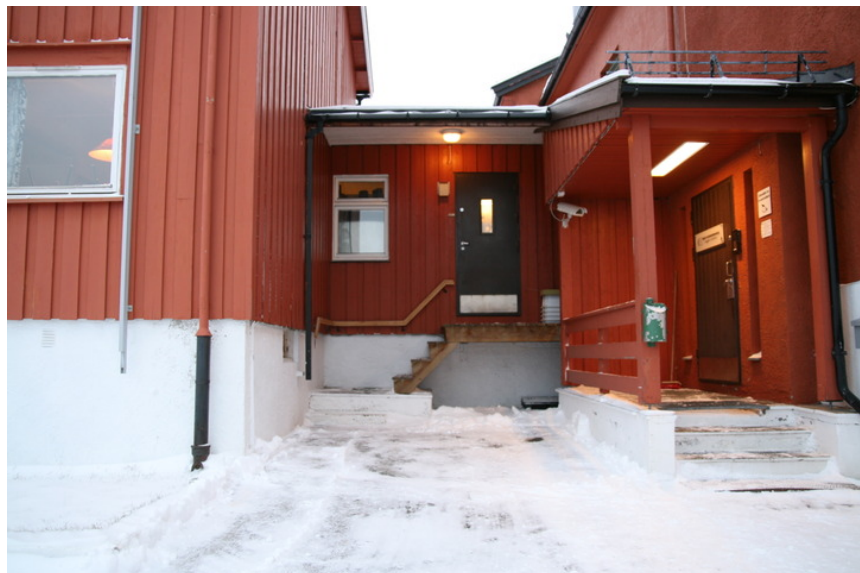
Bindeledd mellom fengsel og Inspektørboligen. Opphavsrett: Statsbygg.
