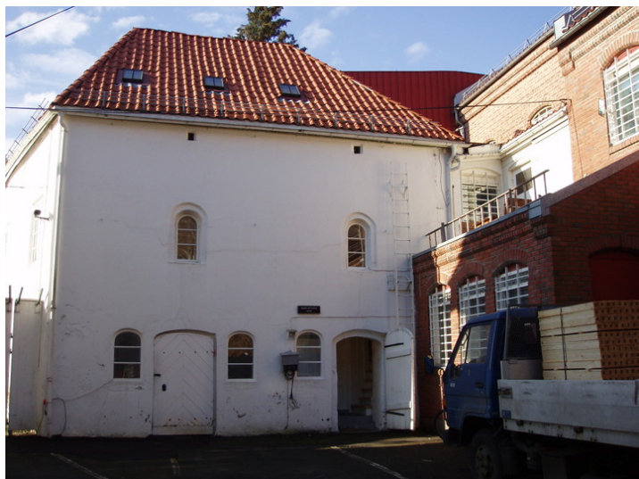
Steinhuset, fasade nord. Opphavsrett: Statsbygg.
