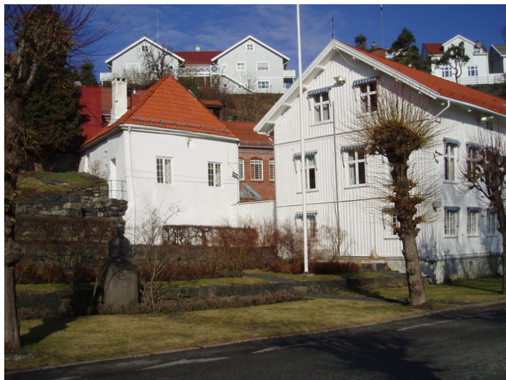
Kragerø fengsel og politistasjon sett fra sør. Opphavsrett: Statsbygg.
