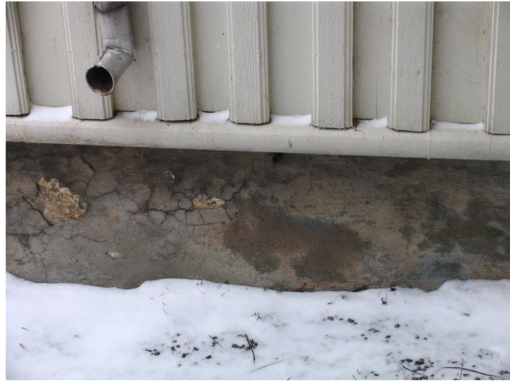
Detalj grunnmur. Opphavsrett: Kriminalomsorgen.
