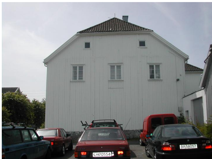
Fasade mot øst. Opphavsrett: Kriminalomsorgen.
