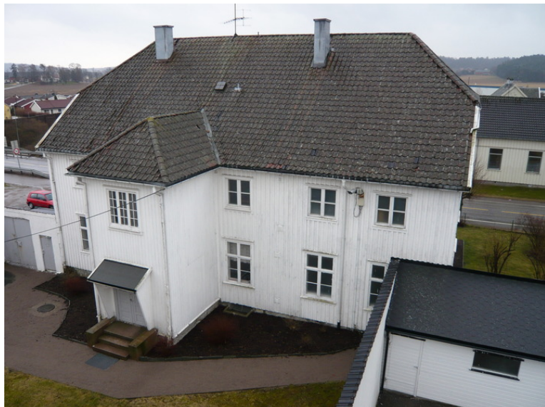
Rettsbygningen før nytt tak ble lagt i 2009. Opphavsrett: Statsbygg.
