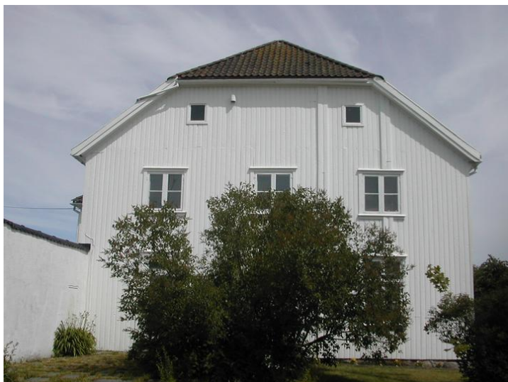
Fasade mot vest. Opphavsrett: Kriminalomsorgen.
