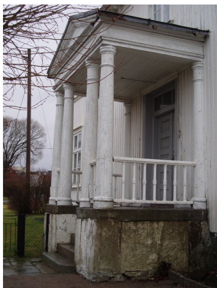
Hovedinngangen er på sydfasaden mot gaten. Opphavsrett: Statsbygg.
