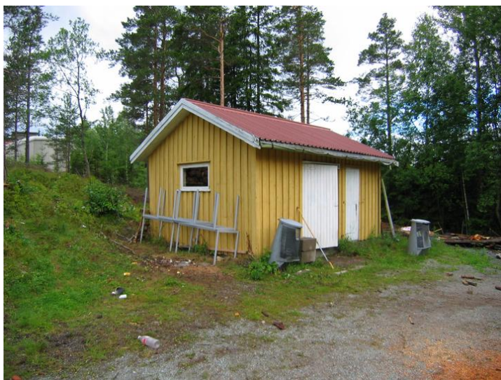
Fasader mot syd og øst. Opphavsrett: Statsbygg.
