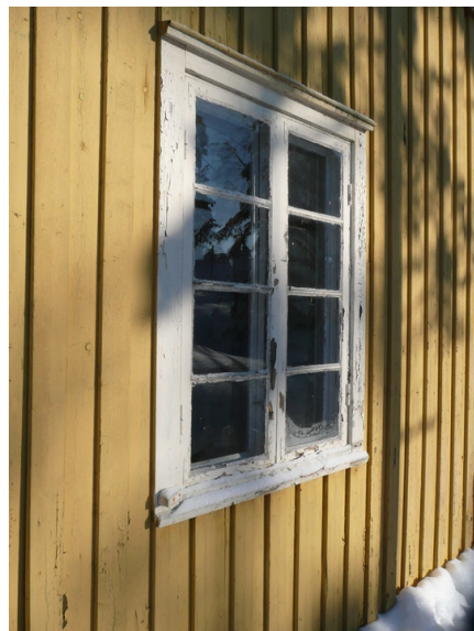
Vinduene er opprinnelige. Opphavsrett: Statsbygg.
