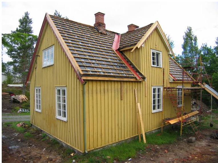
Fasade mot syd og øst. Opphavsrett: Statsbygg.
