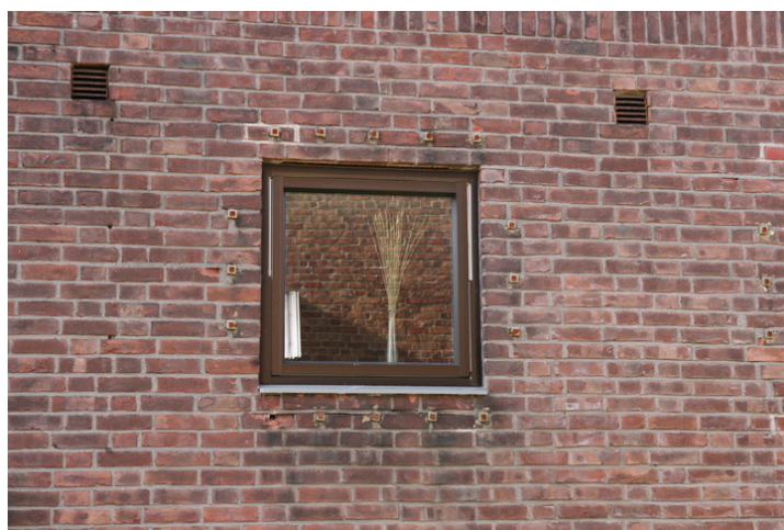
Spor av gitter utenfor tidligere cellevinduer i 1. etasje inn mot bakgården. Opphavsrett: Statsbygg.
