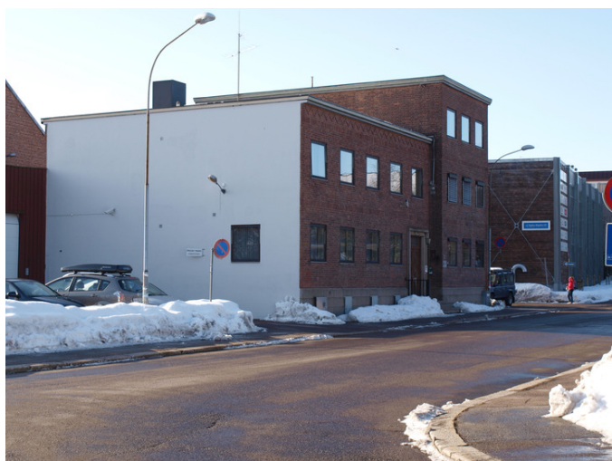
Nordveggen i pusset mur viser hvor bygningen opprinnelig skulle forlenges. Opphavsrett: Statsbygg.
