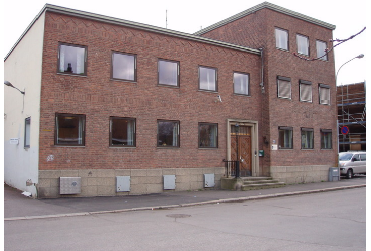
Inngang. Fasaden mot nord, i pusset mur, viser hvor bygget opprinnelig skulle vært forlenget. Opphavsrett: Statsbygg.
