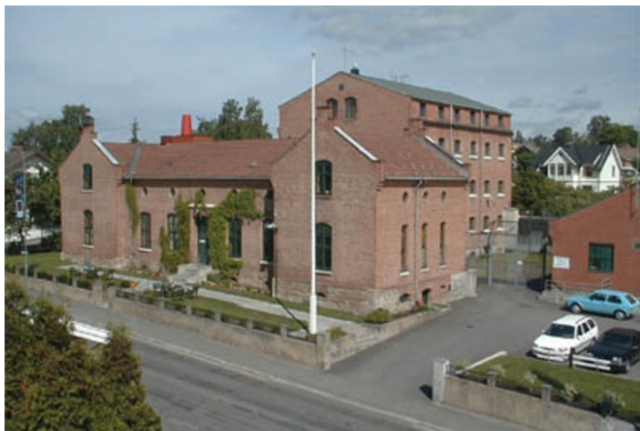
Forbygning med cellebygning i bakgrunnen og verksted til høyre. Opphavsrett: Kriminalomsorgen.
