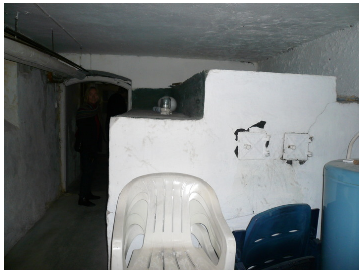
Bakstovn i kjeller under kjøkkenet i forbygningen. Opphavsrett: Statsbygg.
