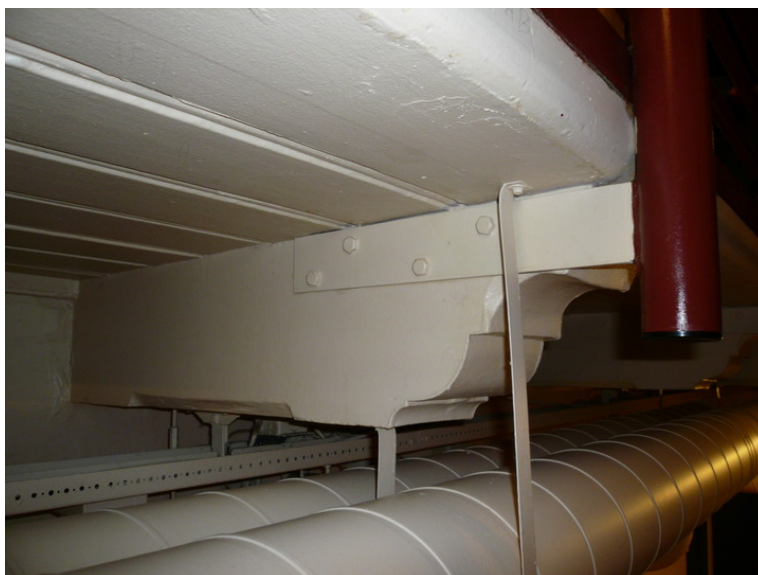
Detalj av bjelkehode, galleri i cellebygningen. Opphavsrett: Statsbygg.
