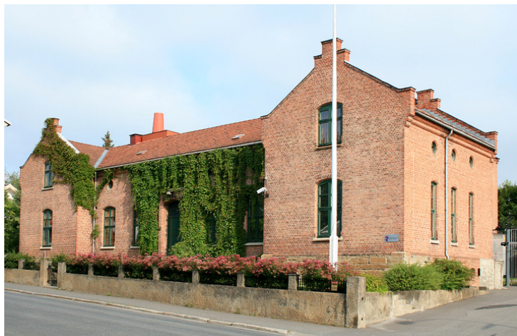
Fasade mot Grønnegata, hovedinngang. Opphavsrett: Statsbygg.
