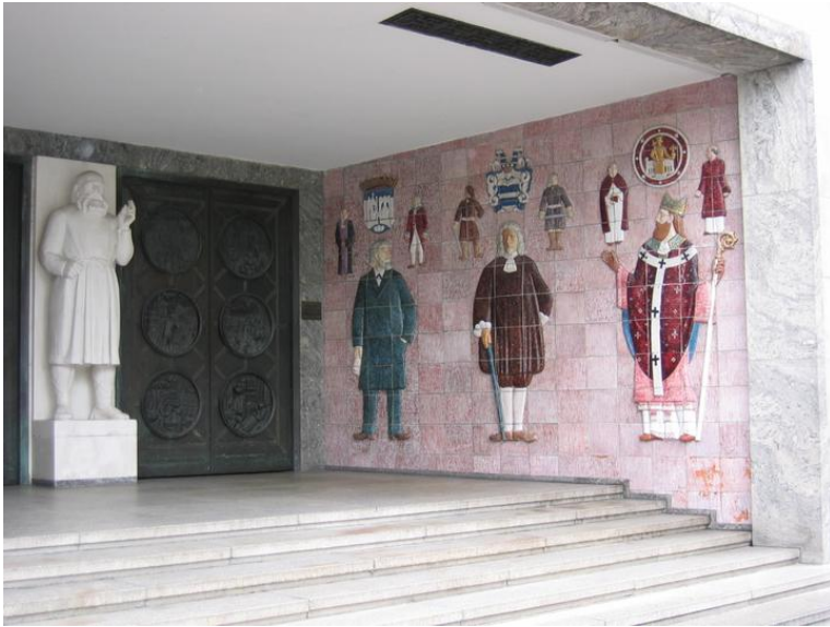
Sørvegg i inngangsparti Foto: Einar Engen Opphavsrett: Statsbygg
