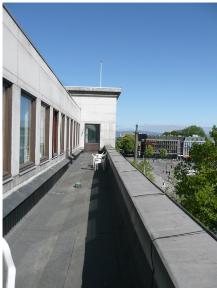
Den påbygde etasjen er trukket inn og ses ikke fra Munkegata. Opphavsrett: Statsbygg.
