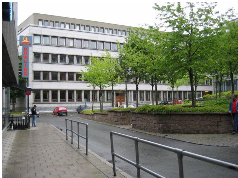
Gårdsplassen bak tinghuset. Her ses tydelig den påbyggde toppetasjen. Opphavsrett: Statsbygg.
