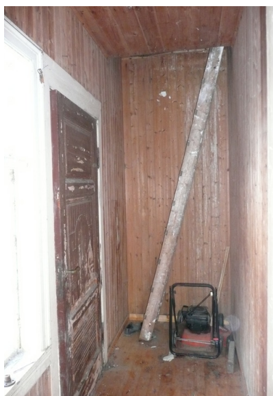
Original panel i uthuset. Opphavsrett: Statsbygg.
