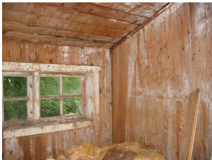
Hønehusets vegg mot øst. Et lite vindu høyt oppe på veggen ga dagslys til rommet. Opphavsrett: Statsbygg.
