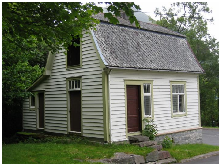
Fasade mot parkeringsplassen. De to dørene på gavlveggen leder inn til hønehuset til venstre og stallen til høyre. Inngang til funksjonærboligen på langveggen. Opphavsrett: Statsbygg.
