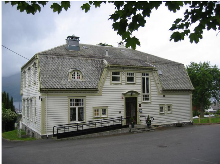
Nordre fasade. Dette var opprinnelig inngangen til boligen mens kontorinngangen var på vestveggen. I dag er dette hovedinngangen. Opphavsrett: Statsbygg.
