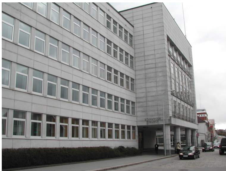
Eksteriør med framskutt inngangsparti. Opphavsrett: Statsbygg.
