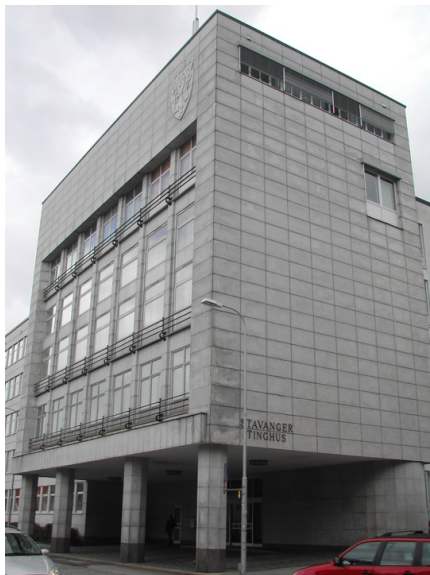
Tårnvolumet med hovedinngang og lagmannsrettssalen. Opphavsrett: Statsbygg
