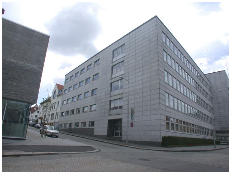
Fasade nord og vest. Foto: Ann- Kristin Strømmen Opphavsrett: Statsbygg.
