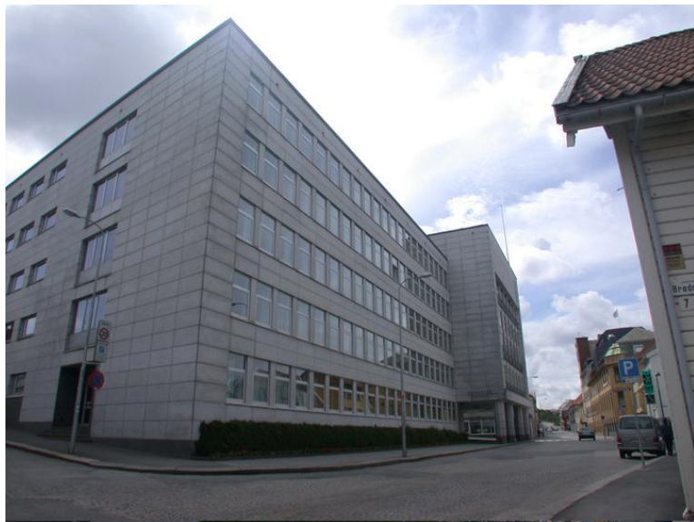
Fasade vest, med tårnvolum mot venstre. Foto: Ann- Kristin Strømmen Opphavsrett: Statsbygg.
