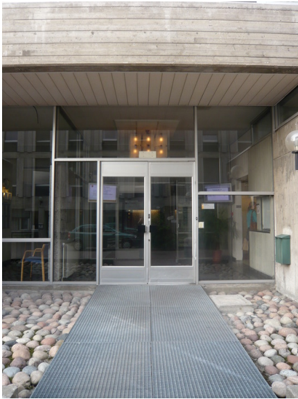
Inngangsparti. Opphavsrett: Statsbygg.
