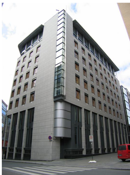
Fasade mot Munchs gt. og Ibsenkvarteret Opphavsrett: Statsbygg.
