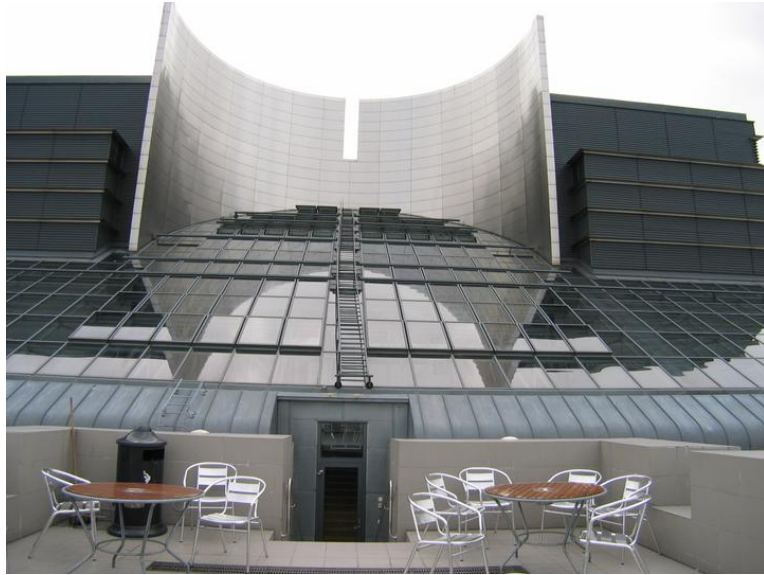
Takterassen med det skrå taket over hovedhallen og 10-etasjes delen av bygget mot Munchs gt. Opphavsrett: Statsbygg.
