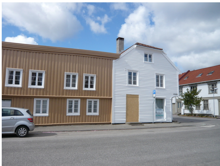
Holbergsgate 17. Opphavsrett: Statsbygg.
