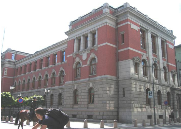
Fasade mot Høyesterettsplass og Akersgata. Opphavsrett: Statsbygg.
