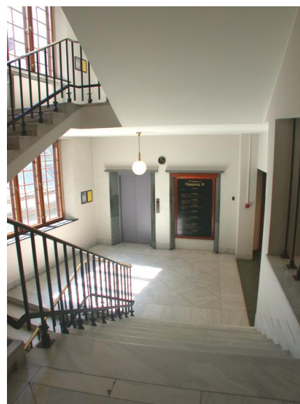
Trappeoppgang. Opphavsrett: Statsbygg
