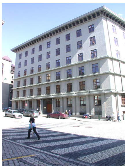
Fasade syd Opphavsrett: Statsbygg.
