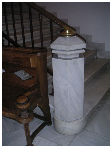
Detalj trapp. Opphavsrett: Statsbygg.
