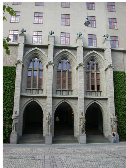
Hovedinngang Bergen tinghus. Opphavsrett: Statsbygg.
