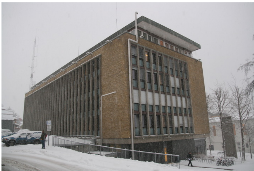
Fasadene mot sør og vest. Opphavsrett: Statsbygg.
