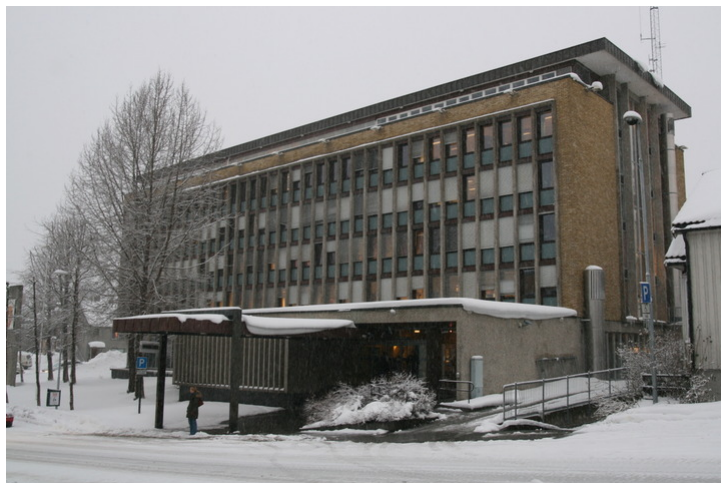
Hovedfasaden mot hovedadkomsten i Grønnegata. Opphavsrett: Statsbygg.
