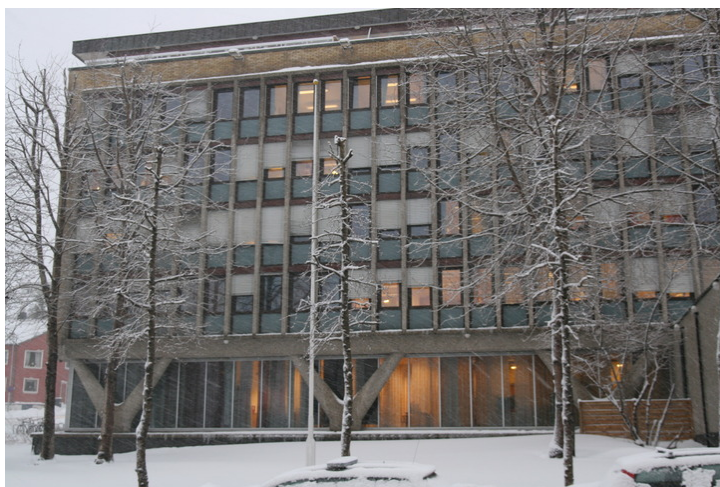
Politihuset. Opphavsrett: Statsbygg.
