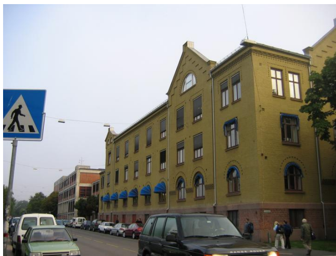
Gardekasernen fra 1907 som ble overtatt av Politiskolen i 1945 i forgrunnen og nybygget fra 1979 til venstre. Opphavsrett: Statsbygg.
