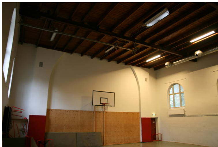
Takkonkstuksjon og himling i gymsalen som i dag er delt i to rom. Opphavsrett: Statsbygg.
