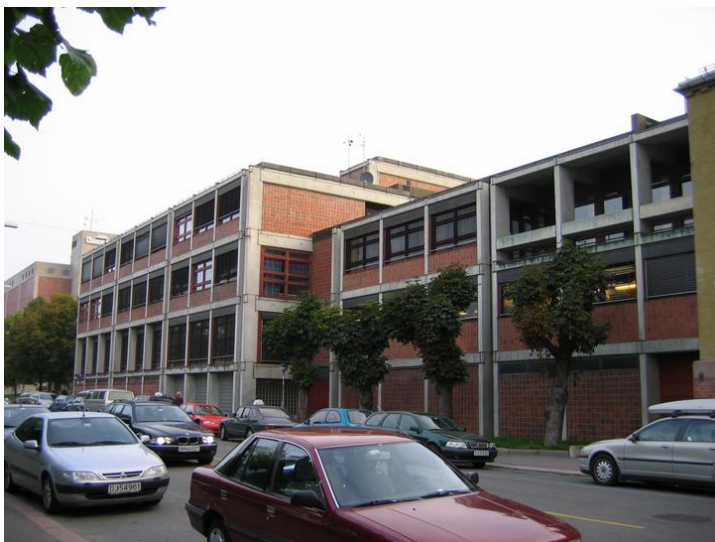
Sørvestfasade, ut mot Slemdalsveien. Opphavsrett: Statsbygg.
