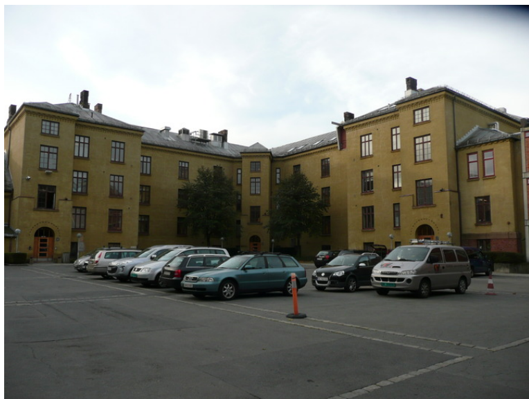
Gardekaserens fasader mot gårdsplassen, opprinnelig eksersisplass som fortsatt brukes til oppstillinger. Opphavsrett: Statsbygg.
