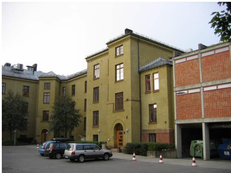
Nørdøstfasade, vestfløy. Overgangen til nybygget fra 1979. Opphavsrett: Statsbygg.
