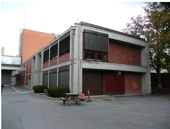
Undervisningsbygningen med garasje, verkstedshall og politistasjon. Inn mot gårdsrommet. Opphavsrett: Statsbygg.
