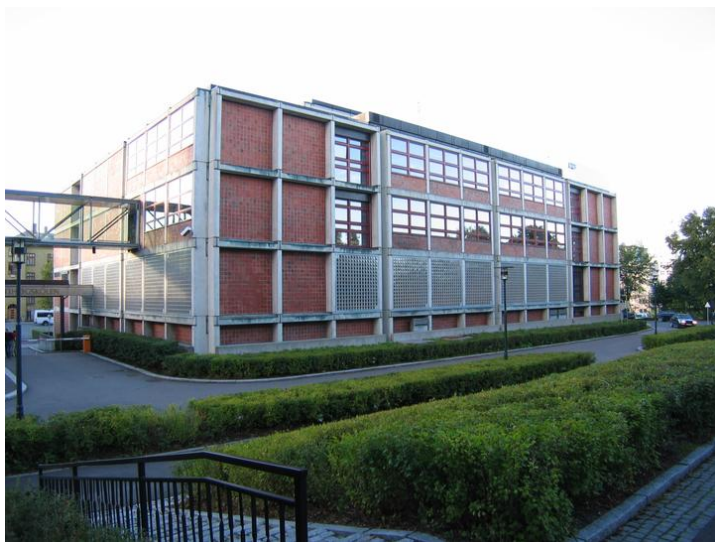
Nordvest- og nordøstfasade. I tillegg vises glasskorridor over til nybygget. fra 1996 Opphavsrett: Statsbygg.
