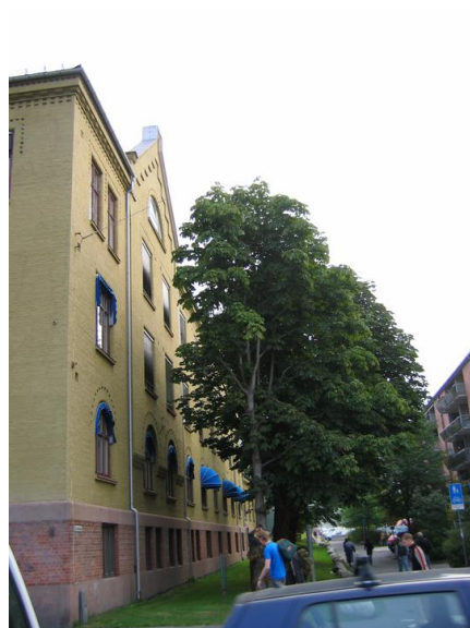
Den sørlige delen av sørøstfasaden Opphavsrett: Statsbygg.
