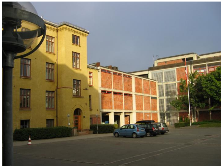
Fasader sett fra gårdsplassen. Gardekasernen t.v. er bundet sammen med skolebygningen (1979) t.h. med et 3-etasjes mellombygg (1979). Opphavsrett: Statsbygg.
