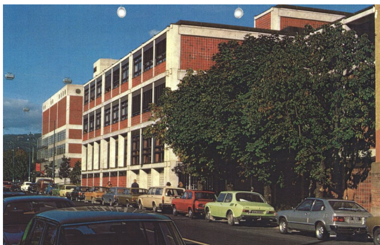
Den daværende Politiskolen fikk i 1979 nye undervisningsbygg mellom Chateau Neuf og den gamle skolebygningen. Opphavsrett: Statsbygg.
