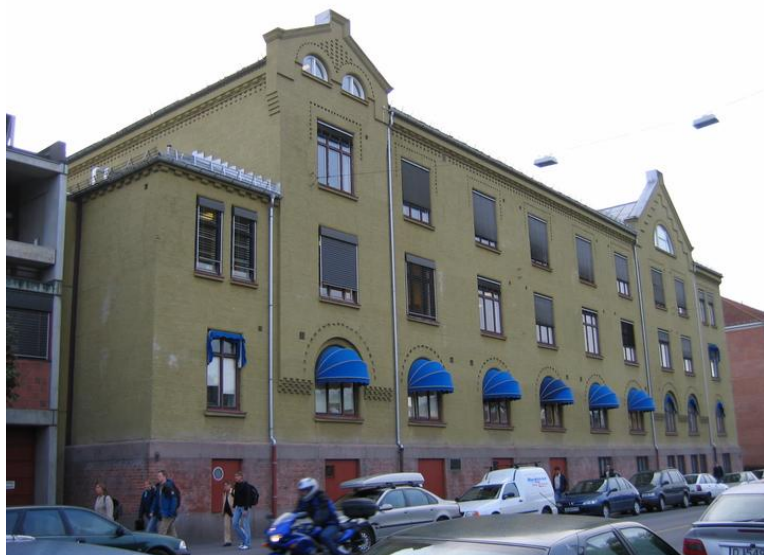
Sørvestfasade, ut mot Slemdalsveien. Opphavsrett: Statsbygg.
