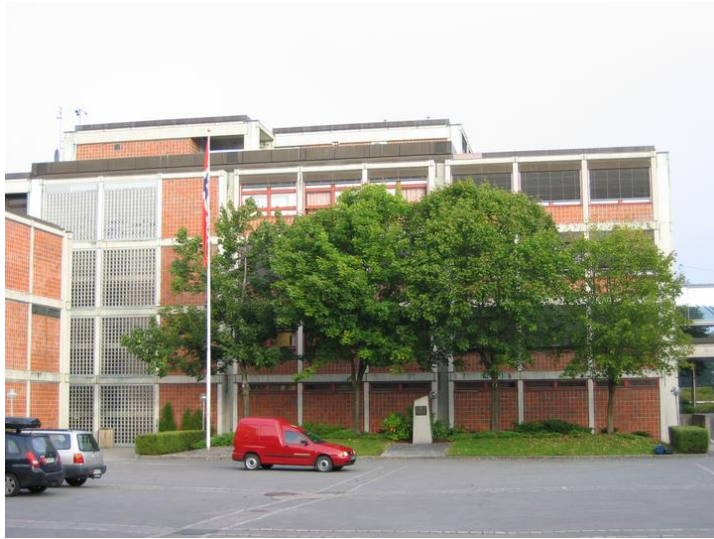
Sørøstfasade, inn mot gårdsplass. Opphavsrett: Statsbygg.
