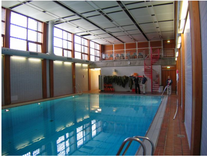
Bassenget i bygningens østlige hjørne før rehabilitering. Opphavsrett: Statsbygg.
