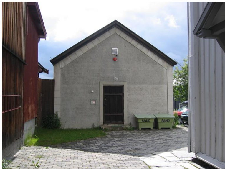
Gavlvegg med inngang til hittegodsrommet. Bildet er tatt fra portrommet. Opphavsrett: Statsbygg.
