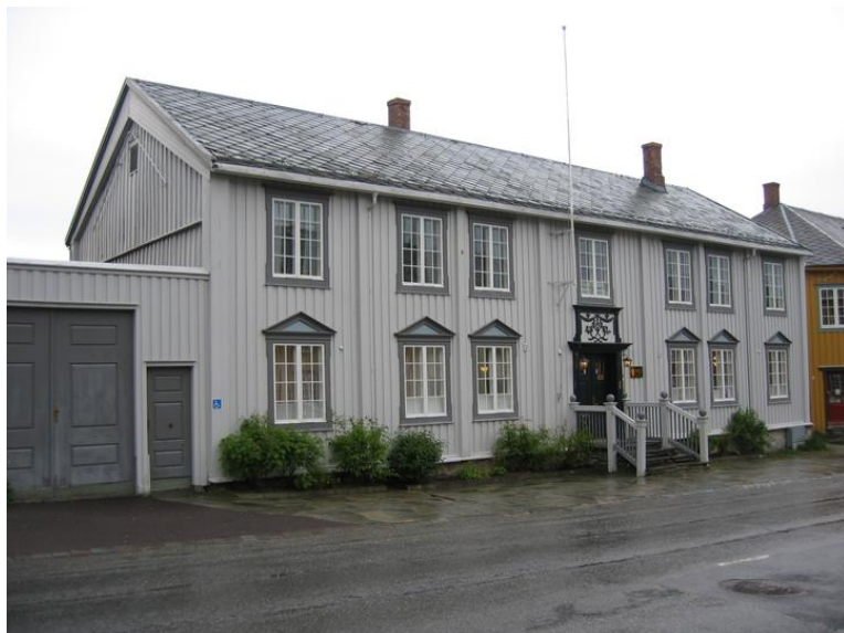
Bergskrivergårdens fasade mot Bergmannsgata. Opphavsrett: Statsbygg.
