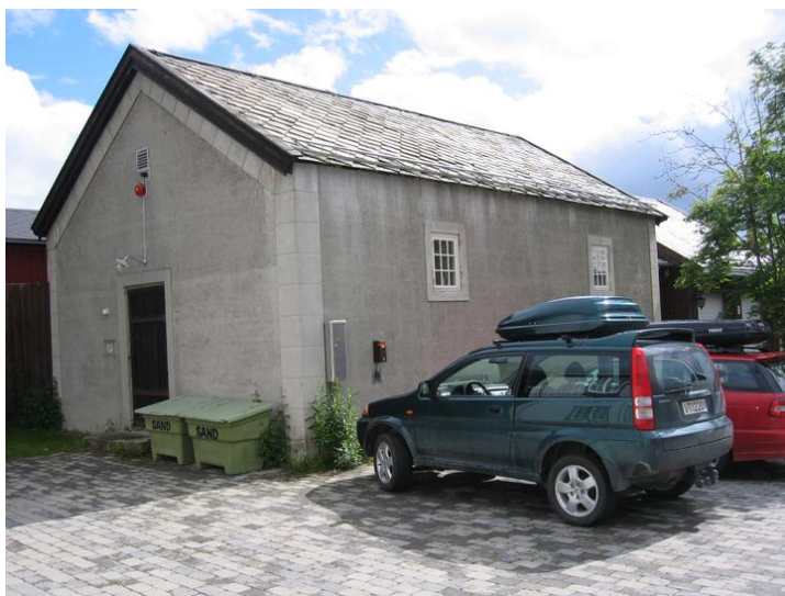
Arkivbygningen sett fra hovedbygningen. Opphavsrett: Statsbygg.
