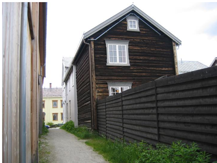
Bergskriverveta med hovedbygning, sidebygning og "planke". Opphavsrett: Statsbygg.
