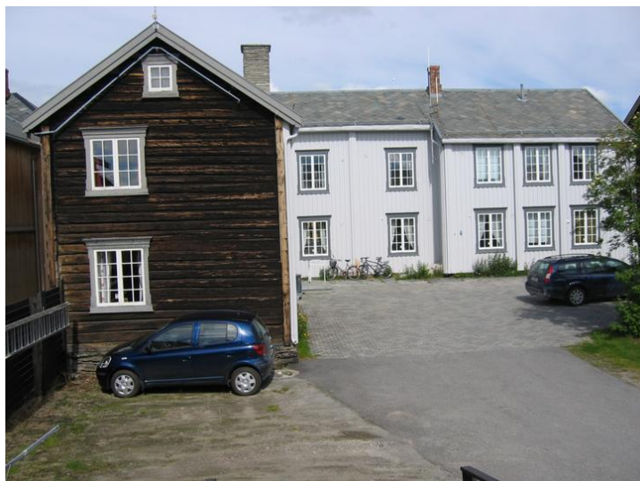
Sidebygningen til venstre er delvis upanelt. Helt til venstre ses et gjerde, "planke", som avgrensning mellom husa. Opphavsrett: Statsbygg.
