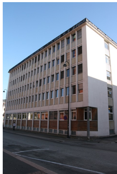
Arendal politistasjon. Fasade mot vest og Trefoldighetskirken. Opphavsrett: Statsbygg.
