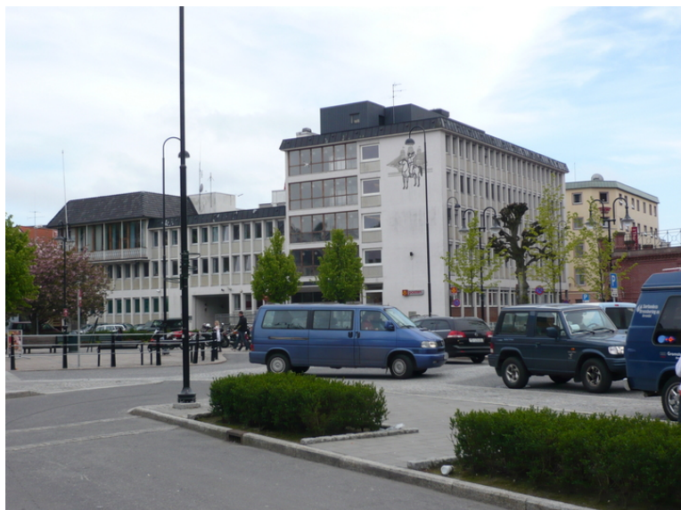
Arendal politistasjon. Fasade sett fra nordvest. Opphavsrett: Statsbygg.
