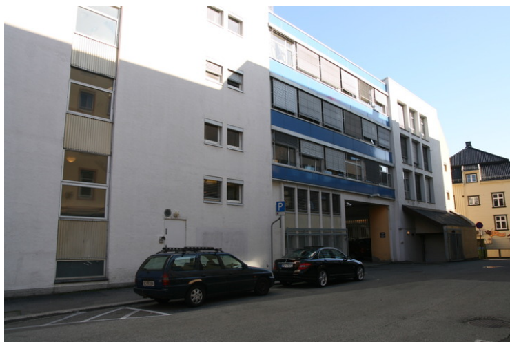
Fasade mot bakgård. Opphavsrett: Statsbygg.
