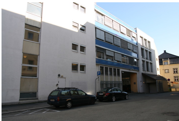
Arendal politistasjon. Fasade mot syd. Bakgården. Opphavsrett: Statsbygg.
