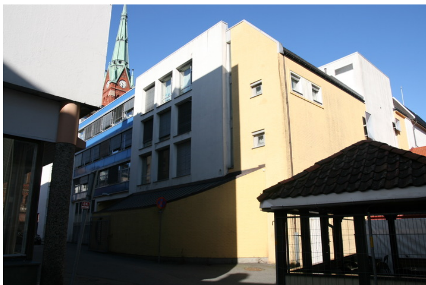
Arendal politistasjon. Fasade mot øst viser nyere påbygg. Opphavsrett: Statsbygg.
