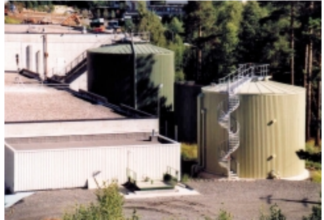
Det nye anlegget i Sellikdalen på Kongsberg.
