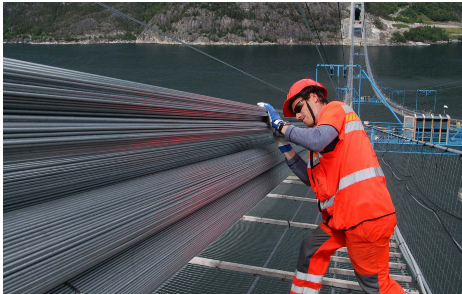
En inspeksjon utføres under byggingen av Hardangerbrua i 2012 - med forskriftsmessig vernetøy.
