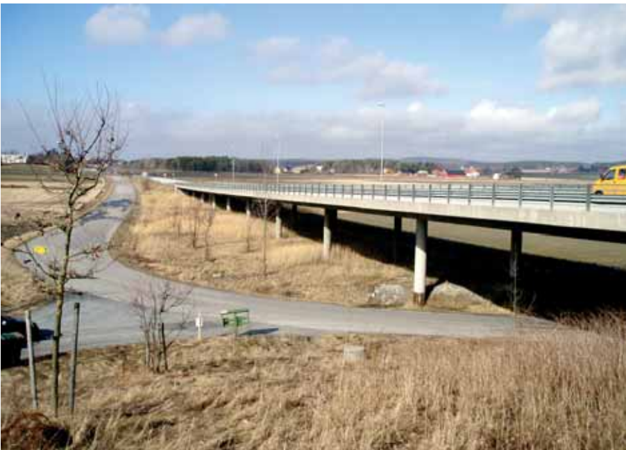
Figur 239.1 Myrbru (Vikshagen bru på E6 i Østfold. Foto: El Hadj Nouri)
