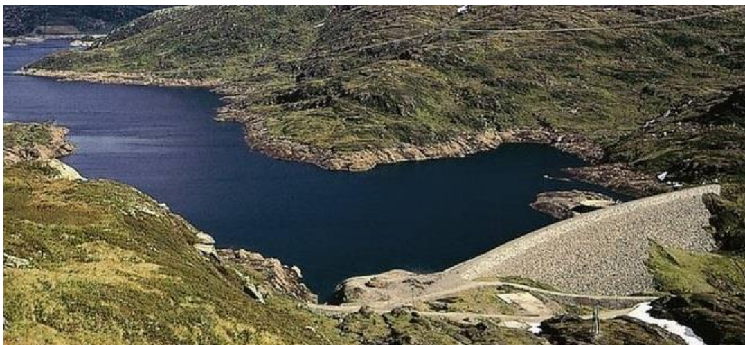
Figur 7-4. Dam Askjeldalsvatn før ombygging
