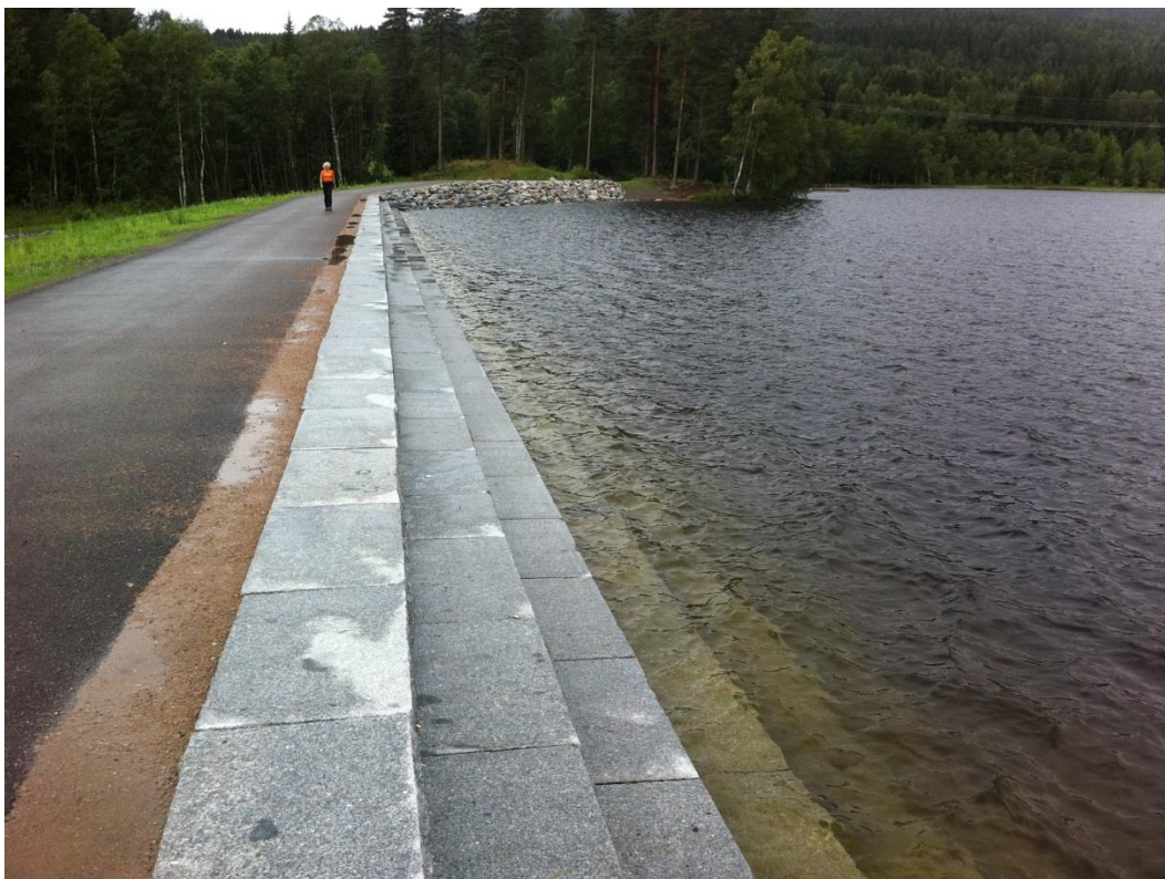
Figur 7-2. Dam Sognsvann etter rehabilitering.
