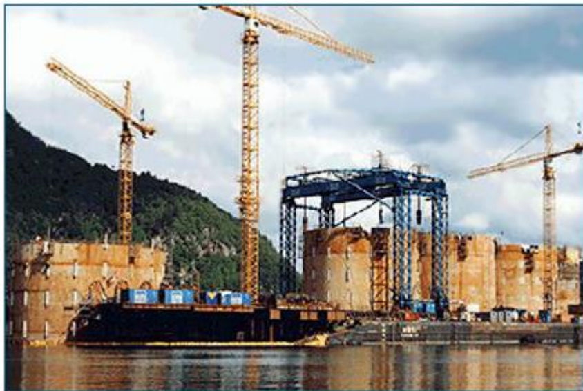
> Figur 9-8: De avkuttede seksjonene ferdig rengjort og plassert på lektene.
