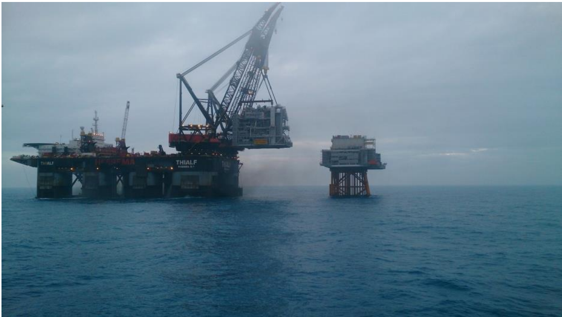
> Figur 7-4: Én av dekksmodulene på Edvard Grieg løftes på plass av Thialf [28]
