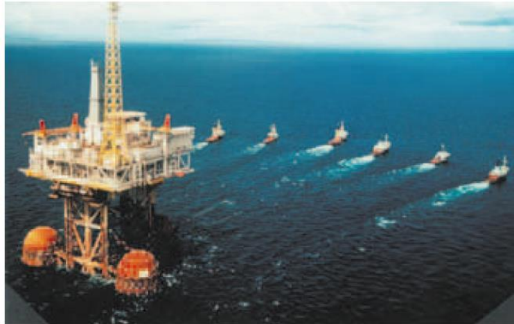
> Figur 8-19: Towing av Maureen etter reflyting [58]
