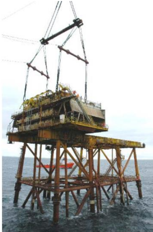
> Figur 7-13: Den siste modulen som ble fjernet fra understellet på Frigg DP2
