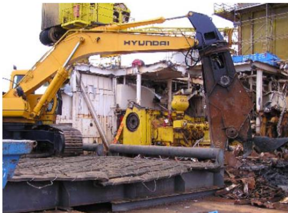
> Figur 7-12: Bit-for-bit fjerning av deler av dekkсанlegget på Frigg DP2
