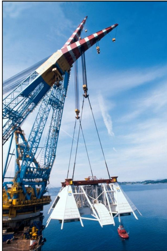
> Figur 10-10: Installasjon av en brønnramme [82]
