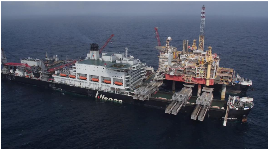
> Figur 7-19: Start av vektoverføring fra plattformunderstell til Pioneering Spirit
