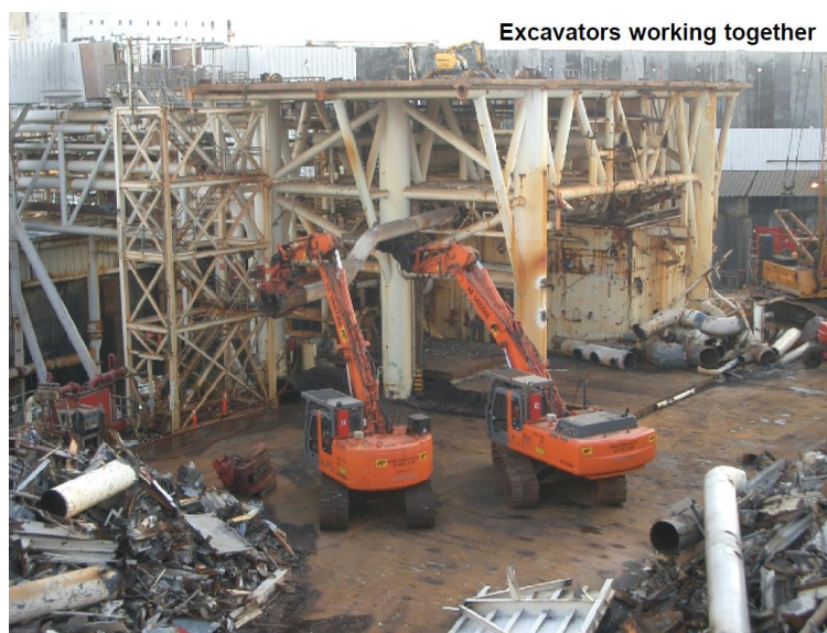
> Figur 7-9: To gravemaskiner som samarbeider ved løft
