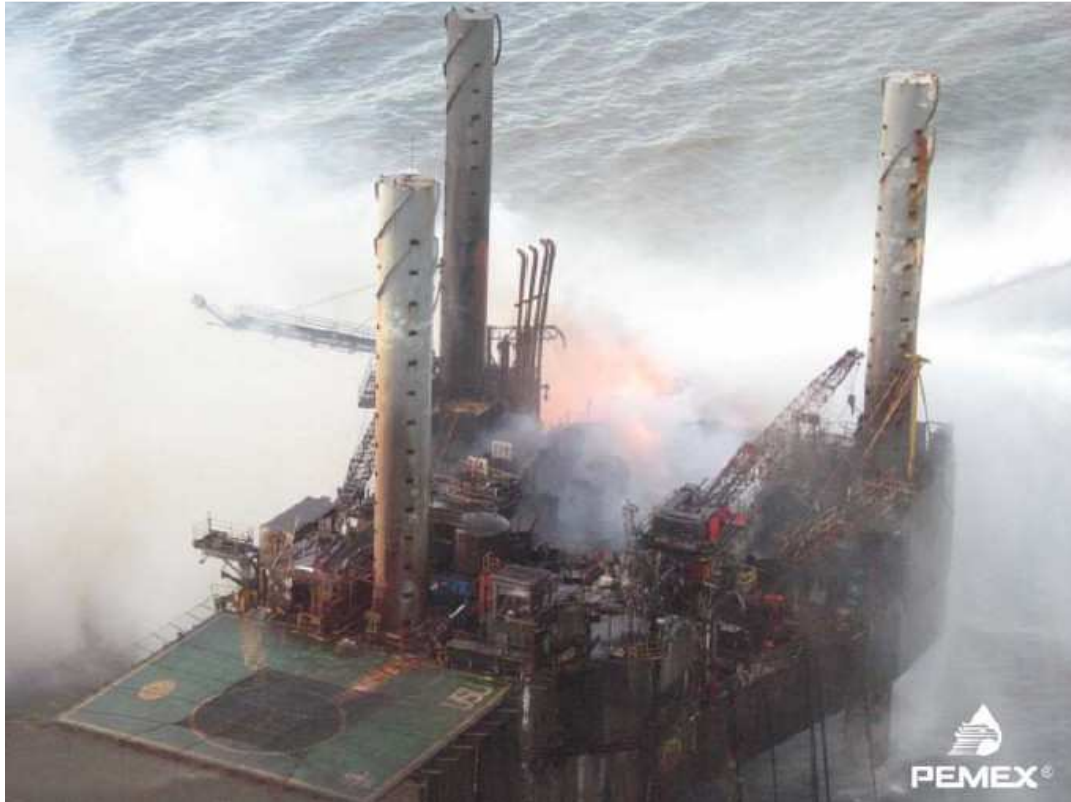
Figur 6-2 Bildene viser den første brannen og riggen etter at cantilever og boretårn har falt ned.
