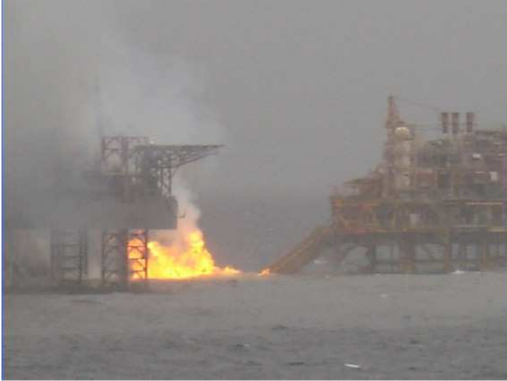
Figur 6-1 Bildet viser jack-up riggen med flammer rundt seg og en kollapset gangbro til en av de andre plattformene på feltet. Etter j-u'ens helidekk å dømme er brannen på motsatt side av cantilever, altså i område hvor boligkvarteret befinner seg.
