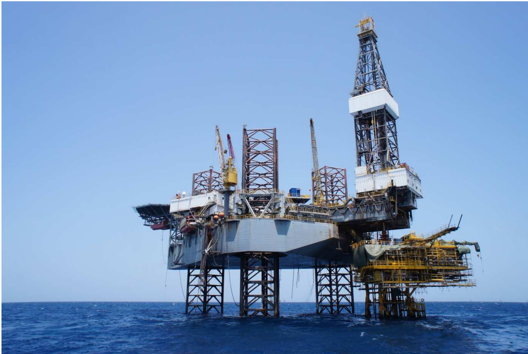
Figur 5-2 Oppjekkbar borerigg over brønnhodeplattform
