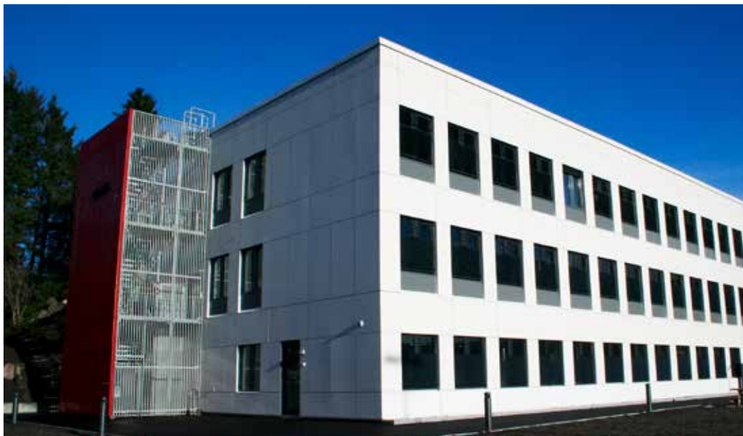
Administrasjonsbygg Haakonvern, byggeår 2015. Den gjennomsnittlige tilstandsgraden påvirkes ikke bare av vedlikehold, men også av avhendinger og nyinvesteringer. Nye bygg begynner på tilstandsgrad 0 (ingen avvik). Foto: Forsvarsbygg
