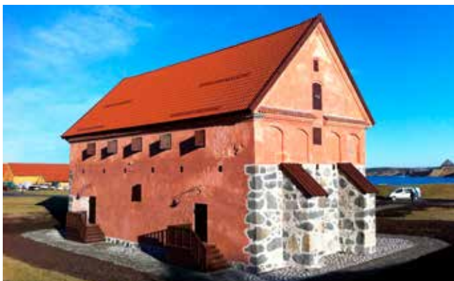
Krutthuset Fredriksvern, byggeår 1779. Gjennom vedlikeholdstiltak i 2012 ble tilstandsgraden forbedret fra 2,47 til 0,55. Foto: Forsvarsbygg
