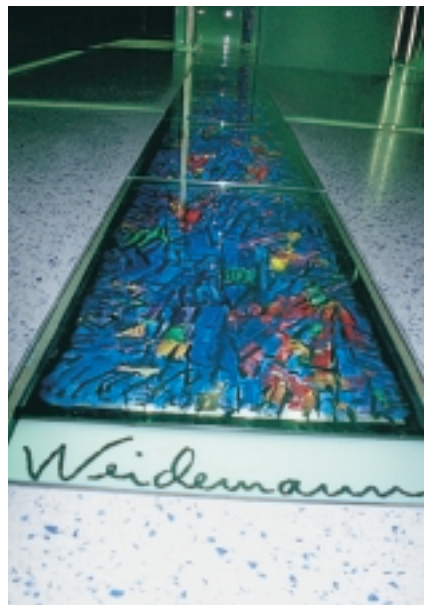
Bildet viser gulv av glassbetong laget av resirkulert glass. Weidemann-rommet i Steinkjer rådhus
