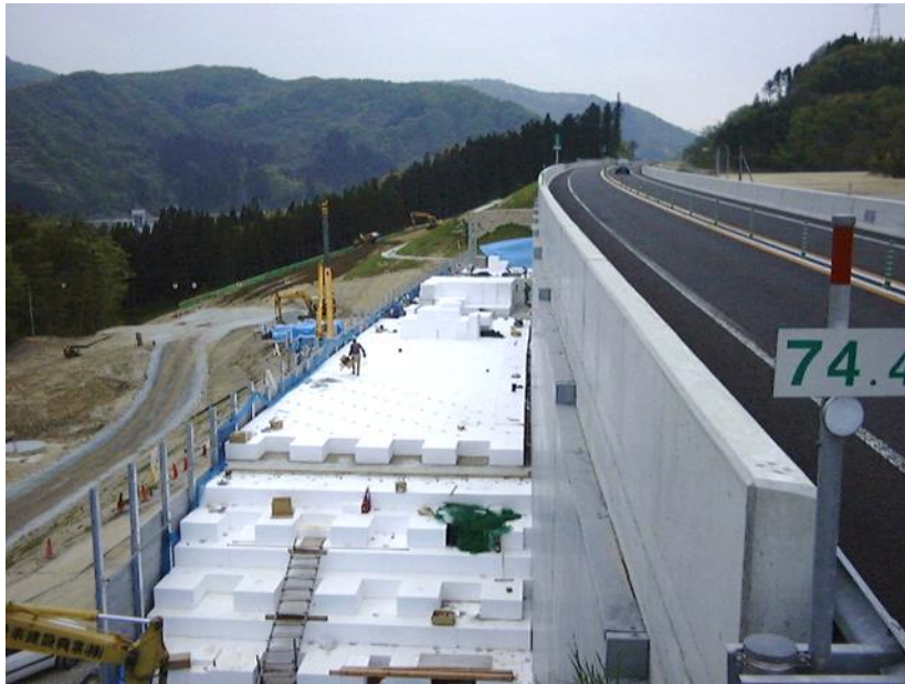
Figur 16. Breddeutvidelse av Yamagata Expressway, Japan med vertikale sidevegger (EDO, Japan)
