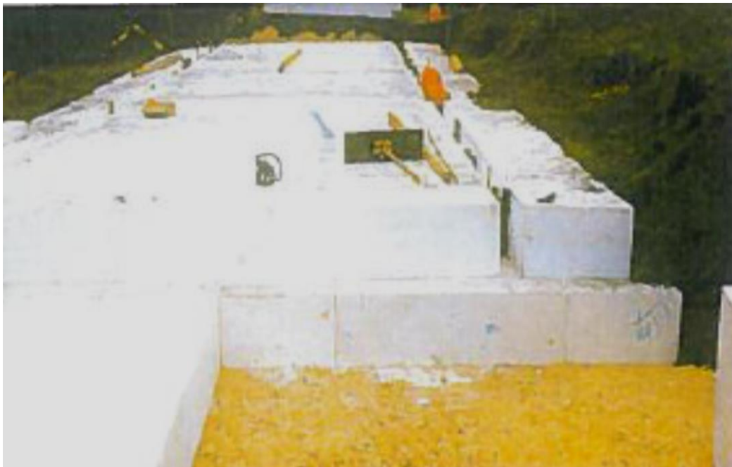
Figur 7. Byggefase for platebru ved Sande rv. 610, med sliss for betongdragere synlig i øvre blokklag (Statens vegvesen)
