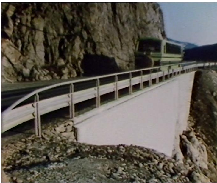
Figur 5. Ferdig EPS-fylling med stålpaneler som utvendig beskyttelse på Rv 5 ved Stedjeberget (Statens vegvesen)
