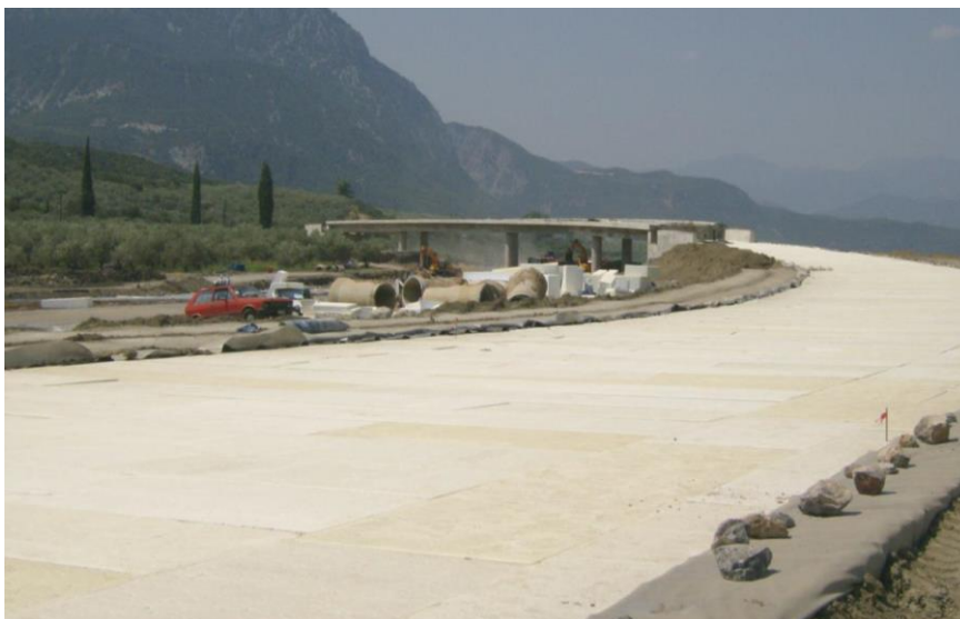
Figur 15. 65.000 m 3 EPS-blokker anvendt for motorveg E 75 ved Thermopylene i Hellas (Sotiropoulos & Associates SA)
