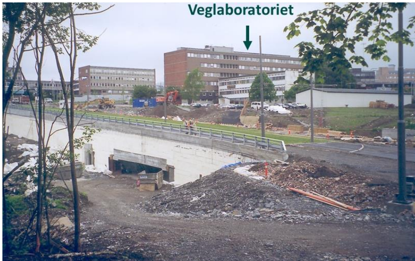
Figur 14. Kombinert fylling for trikketrase og veg foran Veglaboratoriet i Oslo, ca. 15 000 m 3 EPS (Statens vegvesen)
