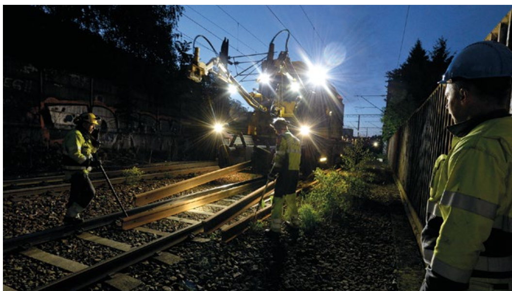
Det er viktig å ha vedlikeholdsarbeidere tilgjengelig når det er tilgang til sporet.
