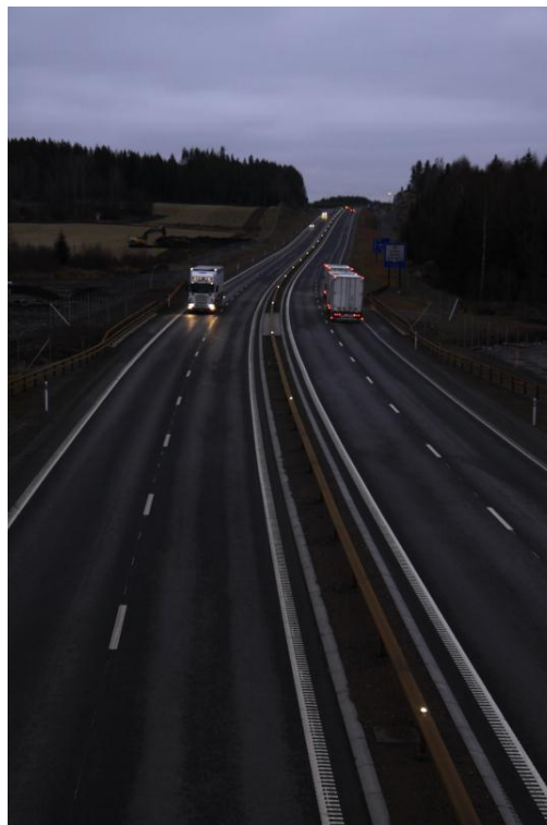
Bilde viser Vegvesenets teststrekning med LED ledelys på E6 mellom Dal-Kolomoen. Bilde hentet fra Vegvesen.no.
