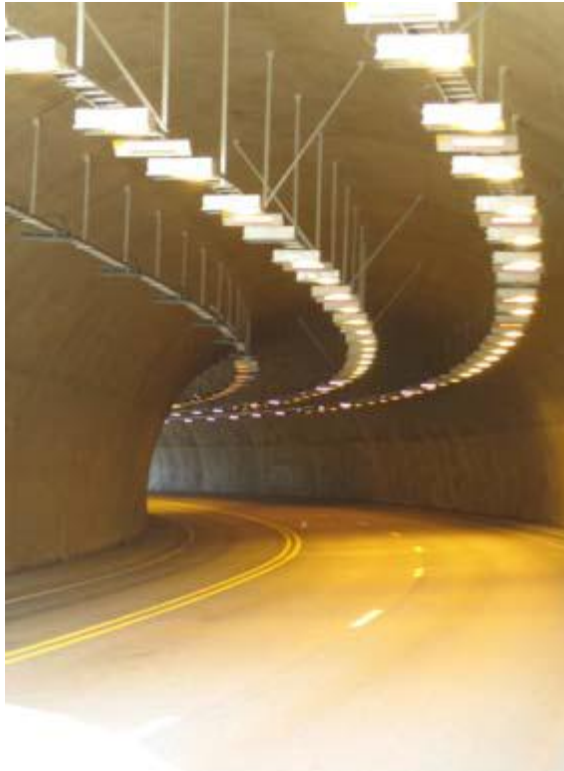
Bilde fra Ljabrudagonalen hentet fra ENØK-prosjektets sluttrapport.
