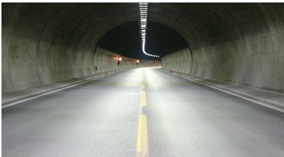
Bilde av Vabakken tunnel med ny LED tunnel belysning for indre sone, bilde fra Norconsult.
